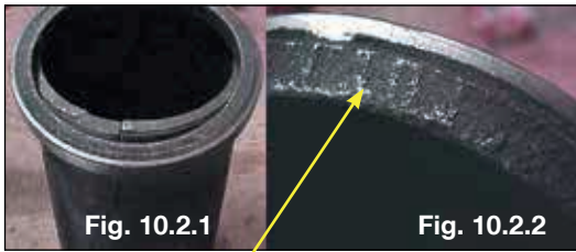
Camisa molhada. Região do colarinho da camisa rompido e carbonizado
