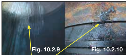
Fig. 10.2.9: Engripamento originado devido ao deslocamento do anel o'ring. Fig. 10.2.10: Impureza no alojamento do anel o'ring na camisa.
