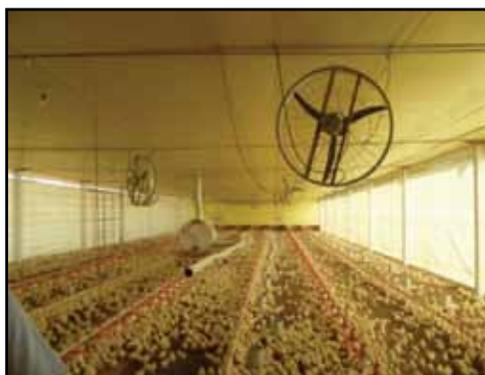
Configuraciones de ventiladores comúnmente encontradas en galpones con ventilación Natural, para galpones de hasta 12 m de ancho, están descritos en orden de eficiencia: 1 = más eficiente, 3= menos eficiente (más de 12 m de ancho resultará en un punto muerto en un lado del galpón, ya que los ventiladores no tienen capacidad de soplar aire a más de 12 m).
