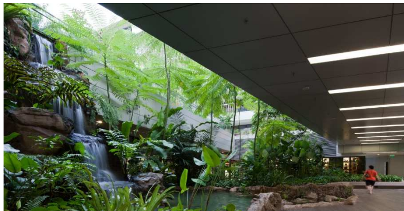
Salto de agua en el patio que ilumina el sótano del KTP
