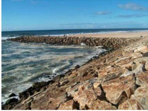
Figura 3.5: Solução mista: Esporão associada à construção de uma obra longitudinal aderente.
