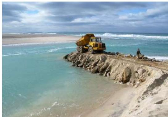
Figura 3.6: Construção de um esporão (pertencente a um campo de esporões).
