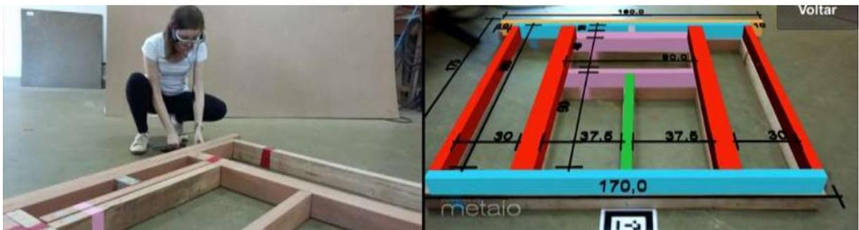
Figura 28 – Montagem de parede de wood-frame com auxílio da Realidade Aumentada (CUPERSCHMID,2016).
