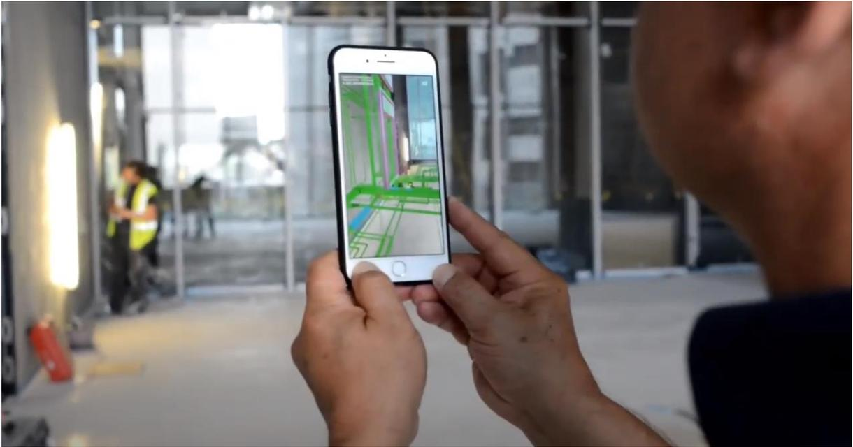
Figura 24 – Visualização de um modelo 3D através do app GAMMA AR num canteiro de obra (GAMMA AR,2020).
