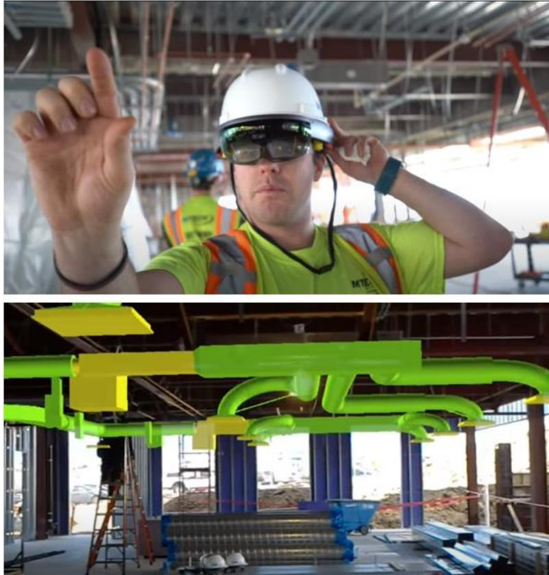
Figura 23 – Trabalhador utilizando o Microsoft HoloLens / Visão do usuário através dos óculos (TRIMBLE,2020).
