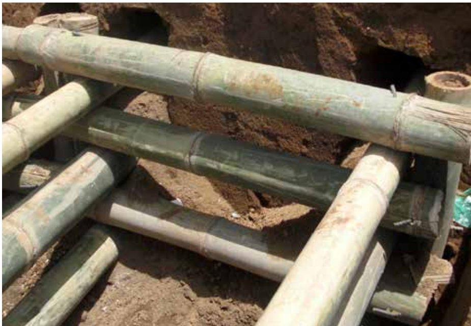
Figura 22. Ejemplo de armado de un disipador (utilizando bambú). La Palma Sur, La Reforma, San Marcos. Fotografía por: Marvin Rabanales y Ana Reyna.
