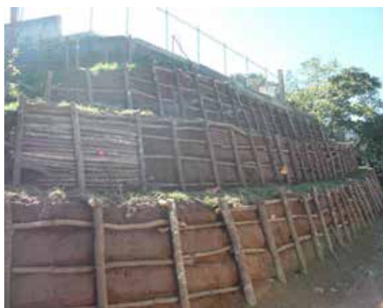
Figura 1. Obra Bioingeniería. La Fraternidad, Esquipulas Palo Gordo, San Marcos. Fotografía por: Marvin Rabanales y Ana Reyna.
