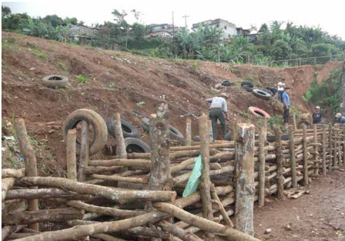
Figura 6. Ejemplo de un entramado de “madera vivo a doble pared”. La Palma Sur, La Reforma, San Marcos. Fotografía por: Marvin Rabanales y Ana Reyna.
