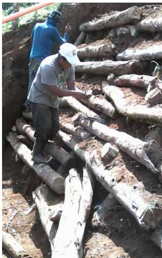
Figura 33. Ejemplo de un armado de “Emparrillado vivo”. El Carrizal, Esquipulas Palo Gordo, San Marcos. Fotografía por: Marvin Rabanales y Ana Reyna.
