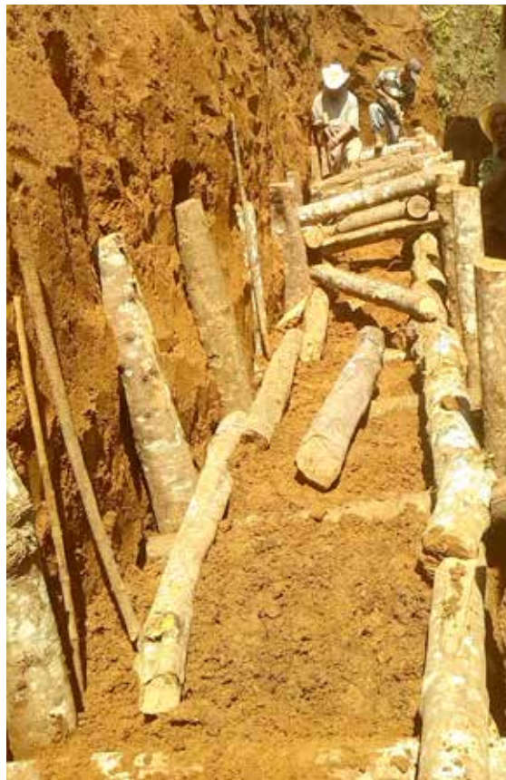
Figura 19. Ejemplo de un armado de “Entramado de madera vivo a doble pared”. El Carrizal, Esquipulas Palo Gordo, San Marcos. Fotografía por: Marvin Rabanales y Ana Reyna.
