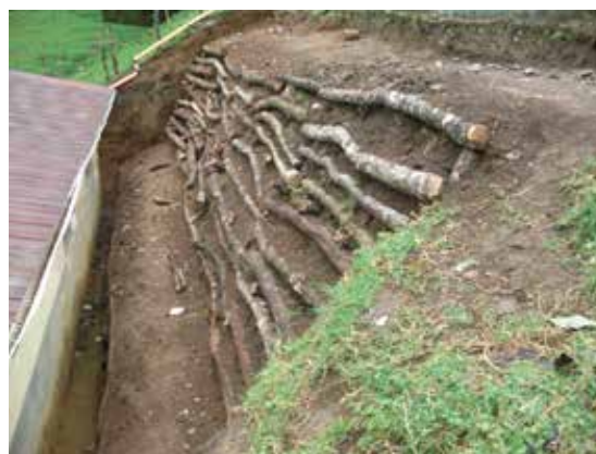
Figura 2. Combinación de Entramado de madera vivo a doble pared y Emparrillado vivo. El Carrizal, Esquipulas Palo Gordo, San Marcos. Fotografía por: Marvin Rabanales y Ana Reyna.
