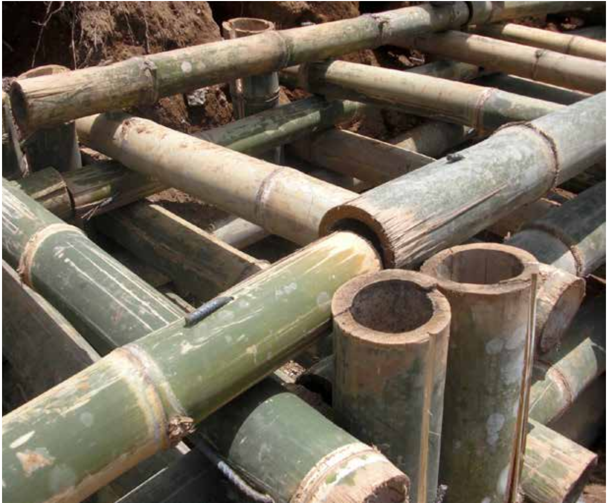
Figura 20. Ejemplo de un de un “Entramado de madera vivo a doble pared” utilizando bambú. La Palma Sur, La Reforma, San Marcos. Fotografía por: Marvin Rabanales y Ana Reyna.
