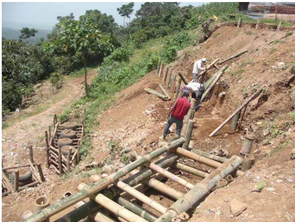
Figura 31. Ejemplo de un armado de “Entramado de madera vivo a doble pared”. La Palma Sur, La Reforma, San Marcos. Fotografía por: Marvin Rabanales y Ana Reyna.
