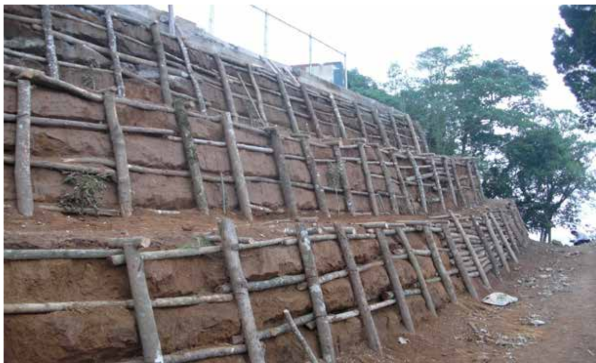
Figura 27. Ejemplo de un “Entramado de madera vivo a doble pared”. La Fraternidad, Esquipulas Palo Gordo, San Marcos. Fotografía por: Marvin Rabanales y Ana Reyna.
