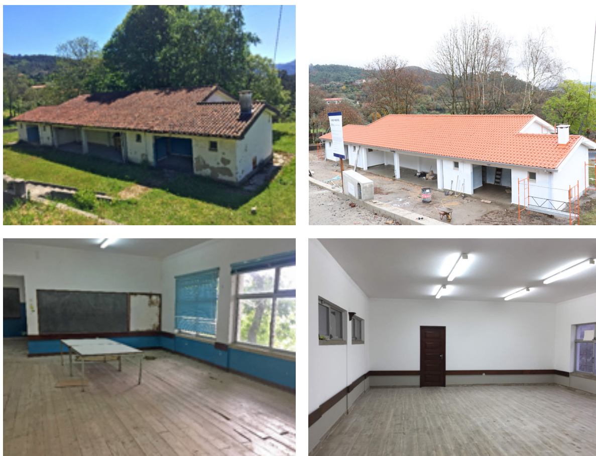
Figura 9: Escola Primária de Seramil antes e durante a intervenção.
