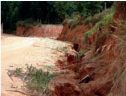
Figura 3. Perigosa vala de erosão em estrada rural municipal, em Campinas, SP. Foto: Paulo Espíndola Trani, 2005 (Instituto Agronômico, SP)
