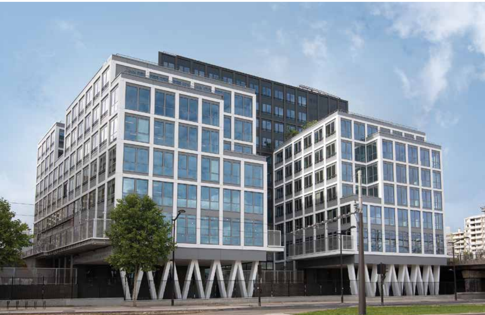
Edificio Chapelle Internationale en París, ejecutado con productos STAC
