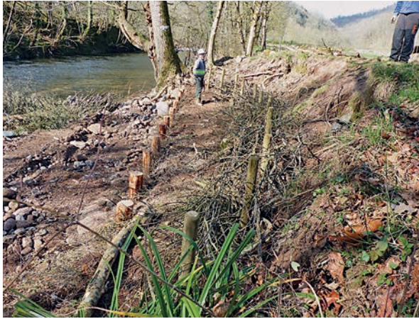
Colocación de material vegetal vivo y cubrimiento con piedra y áridos
