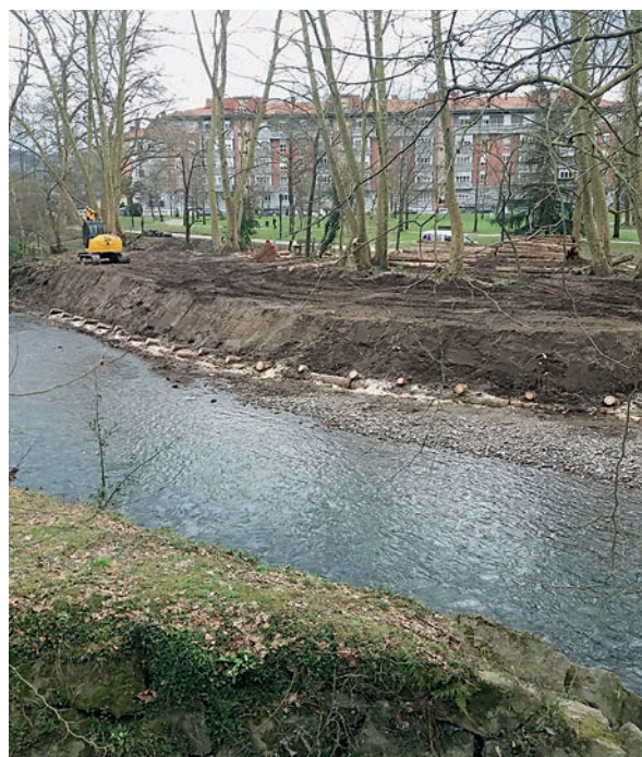
Estabilización de la base del talud mediante entramado de madera tipo Krainer. Colocación longitudinal de troncos
