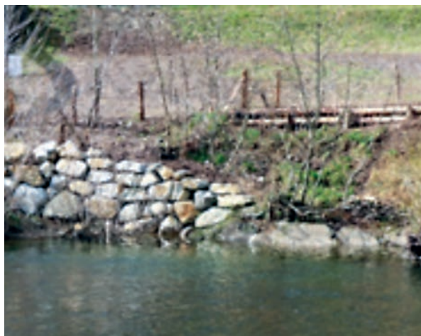
Imagen de la terminación de la escollera. Escollera vegetada
