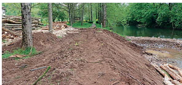
Reperfilado talud, colocación de varas, detalle del cosido y primera crecida
