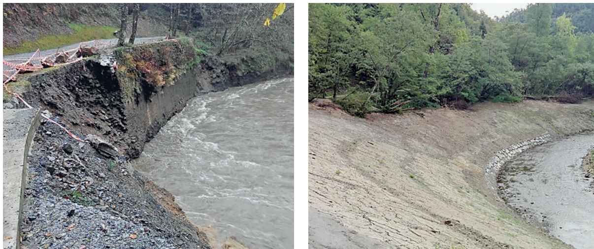
Erosión al pie del terraplén y lavado de material
