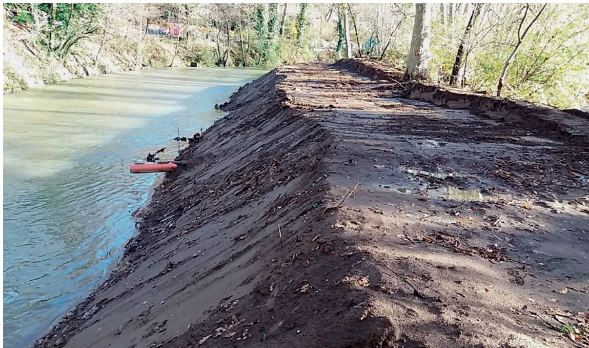
Retaluzado de talud
