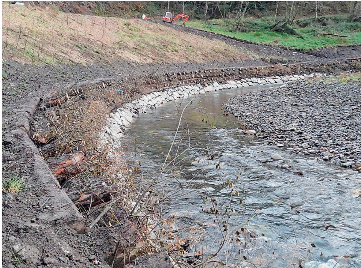
Encuentro final del entramado con el terraplén existente
