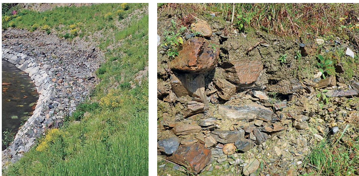
Erosión al pie del terraplén y lavado de material
