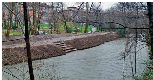
Recubrimiento con tierra vegetal
