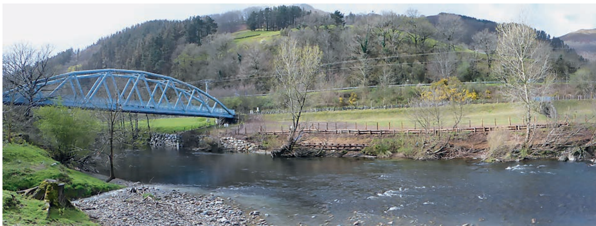
Imagen de la obra recién terminada
