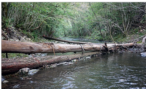
T200: Presa 7+205 apenas ejecutada y tras un año
