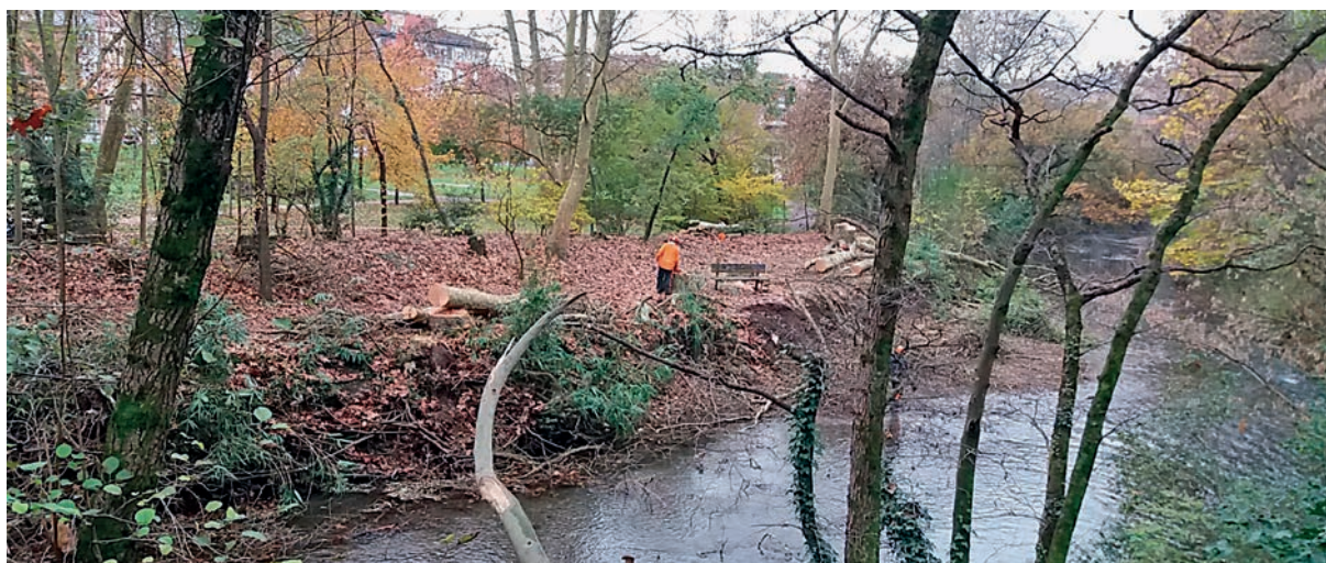
Eliminación del arbolado
