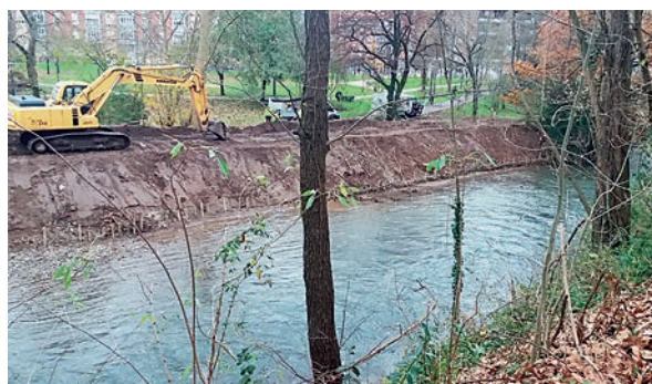
Recubrimiento con tierra vegetal
