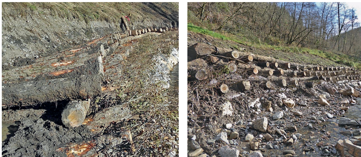
Encuentro final del entramado con el terraplén existente
