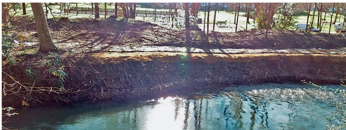
Manta orgánica en la parte alta del talud
