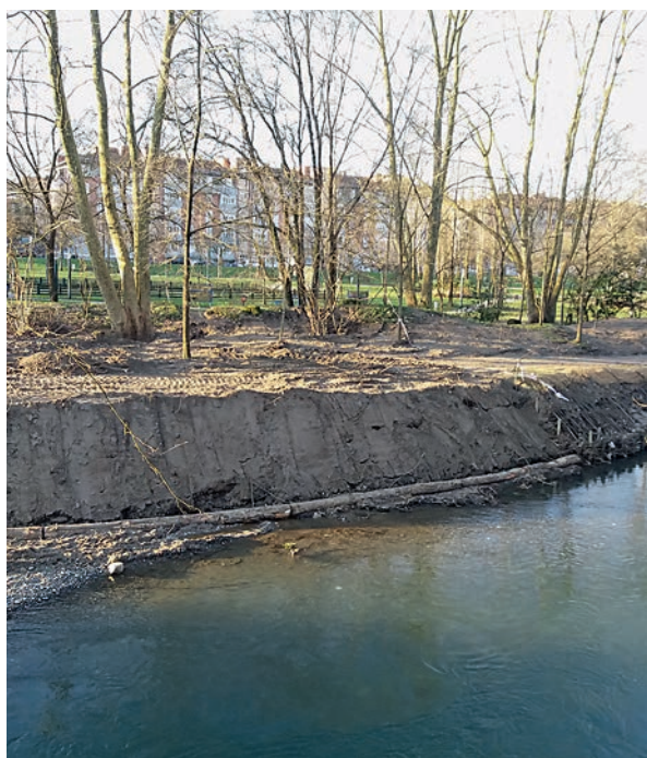
Estabilización de la base del talud mediante entramado de madera tipo Krainer. Colocación longitudinal de troncos
