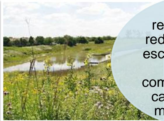
Bacias de retenção, para reduzir o pico do escoamento para um nível compatível com a capacidade do meio receptor
