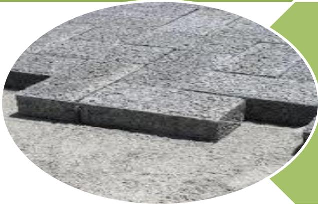
Este tipo de pavimento reduz o escoamento superficial em até 100%, dependendo da intensidade da chuva, e sua característica principal é o retardamento da chegada da água ao subleito, diminuindo assim a erosão.
