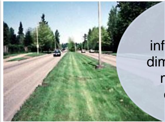
Bacias de infiltração, para diminuir a vazão máxima das enchentes;
