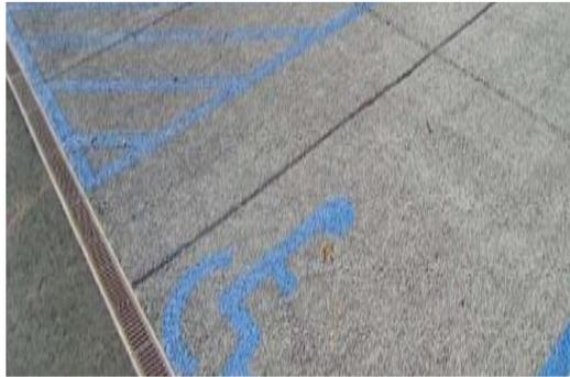
O concreto poroso moldado in loco possui poros que permitem a infiltração de água, para isso utilizam-se agregados com poucos ou sem finos, resultando nos vazios por onde a água passa.
