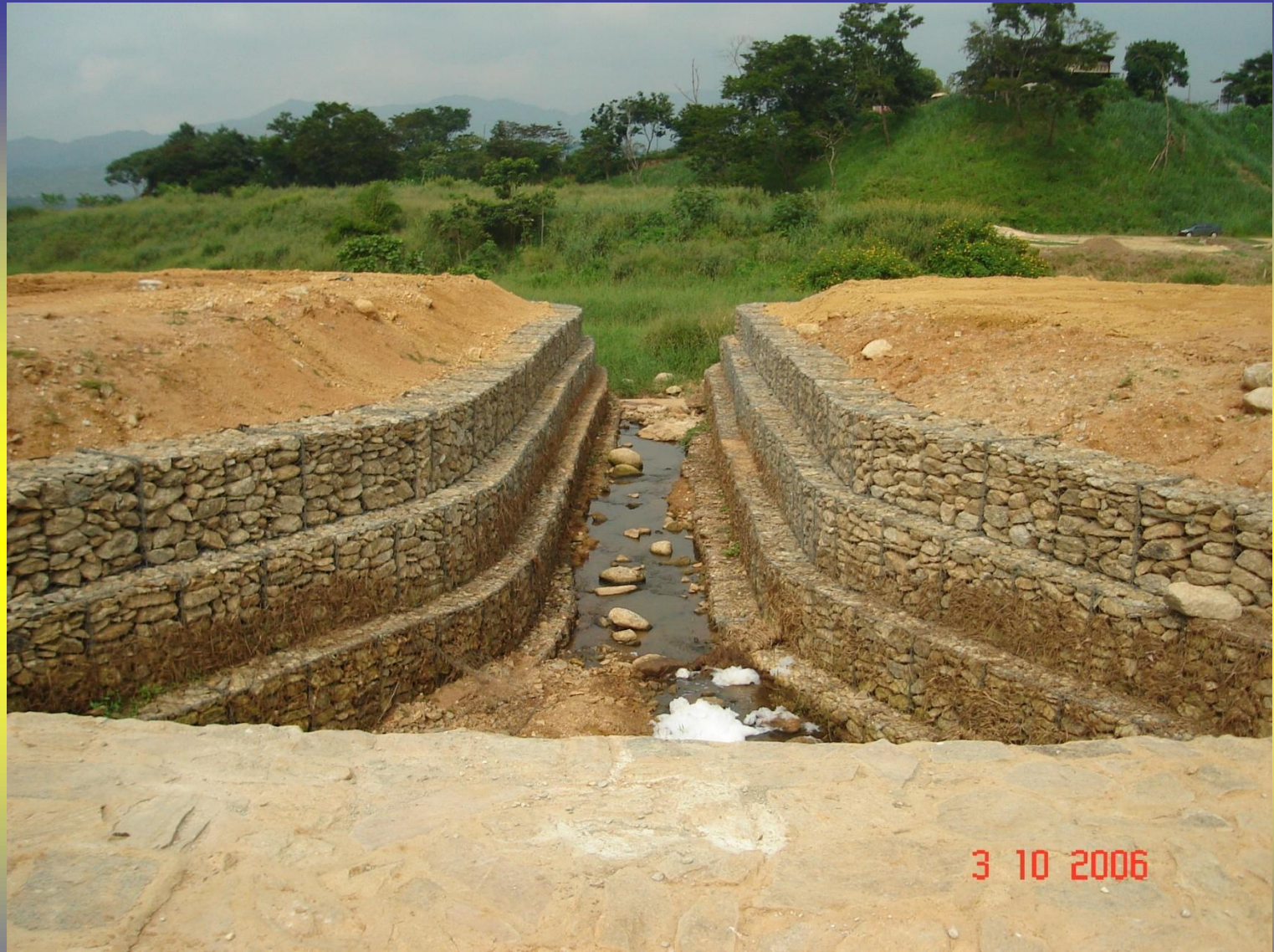
OBRAS DE CONTROL DE DRENAJES CLUB GUATAPARO COUNTRY CLUB, VALENCIA, ESTADO CARABOBO.
