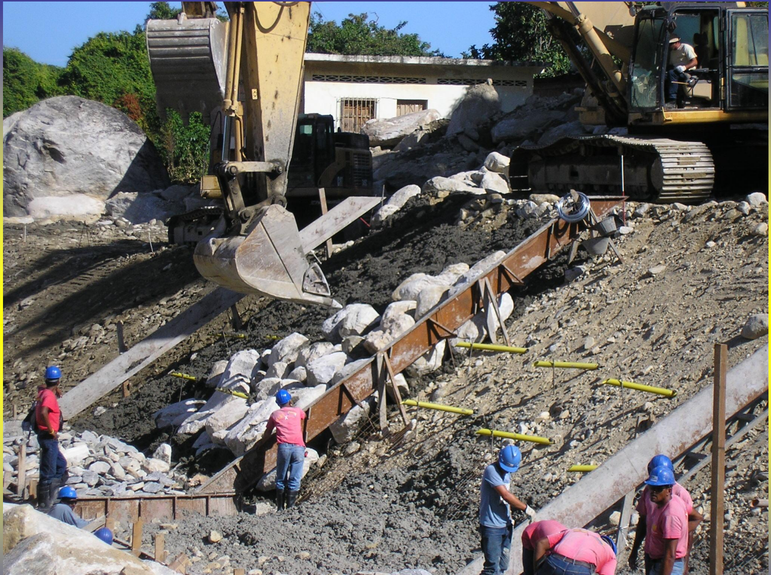
PROTECCION DE MARGEN DEL RIO SAN JULIAN, ESTADO VARGAS.
