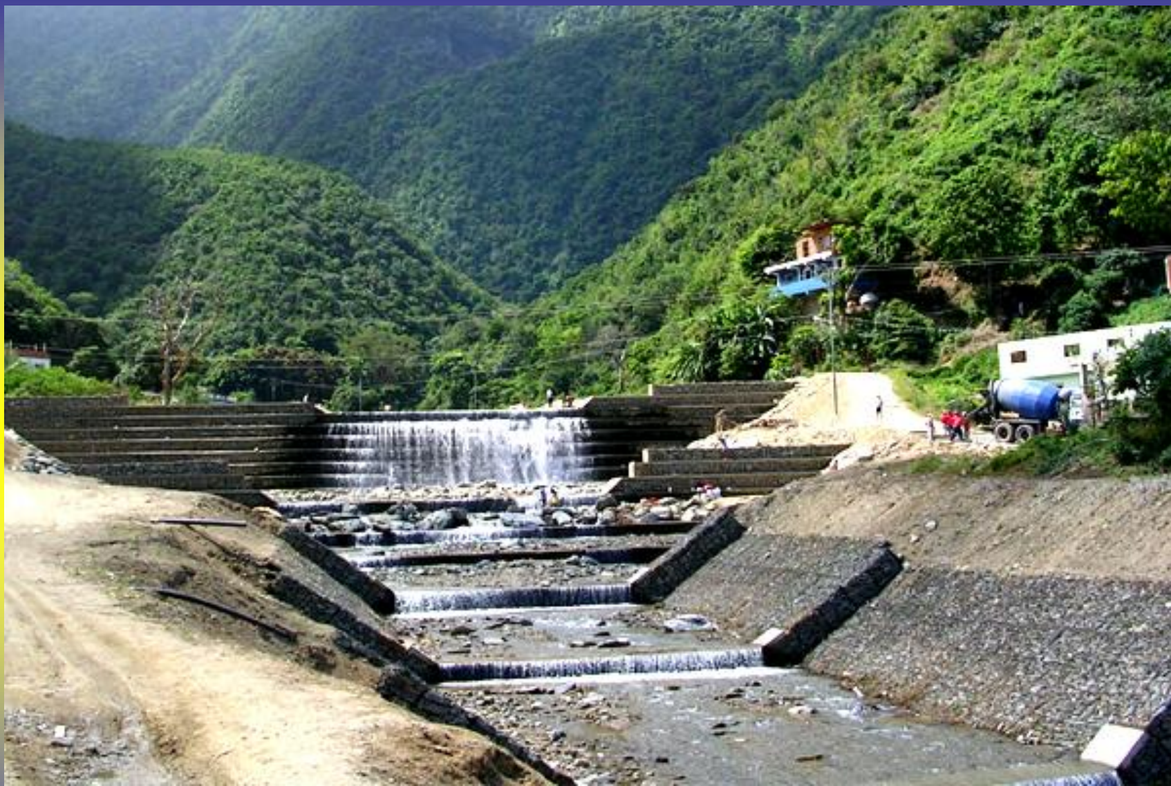
PRESA N° 3.- RIO MACUTO, ESTADO VARGAS.
