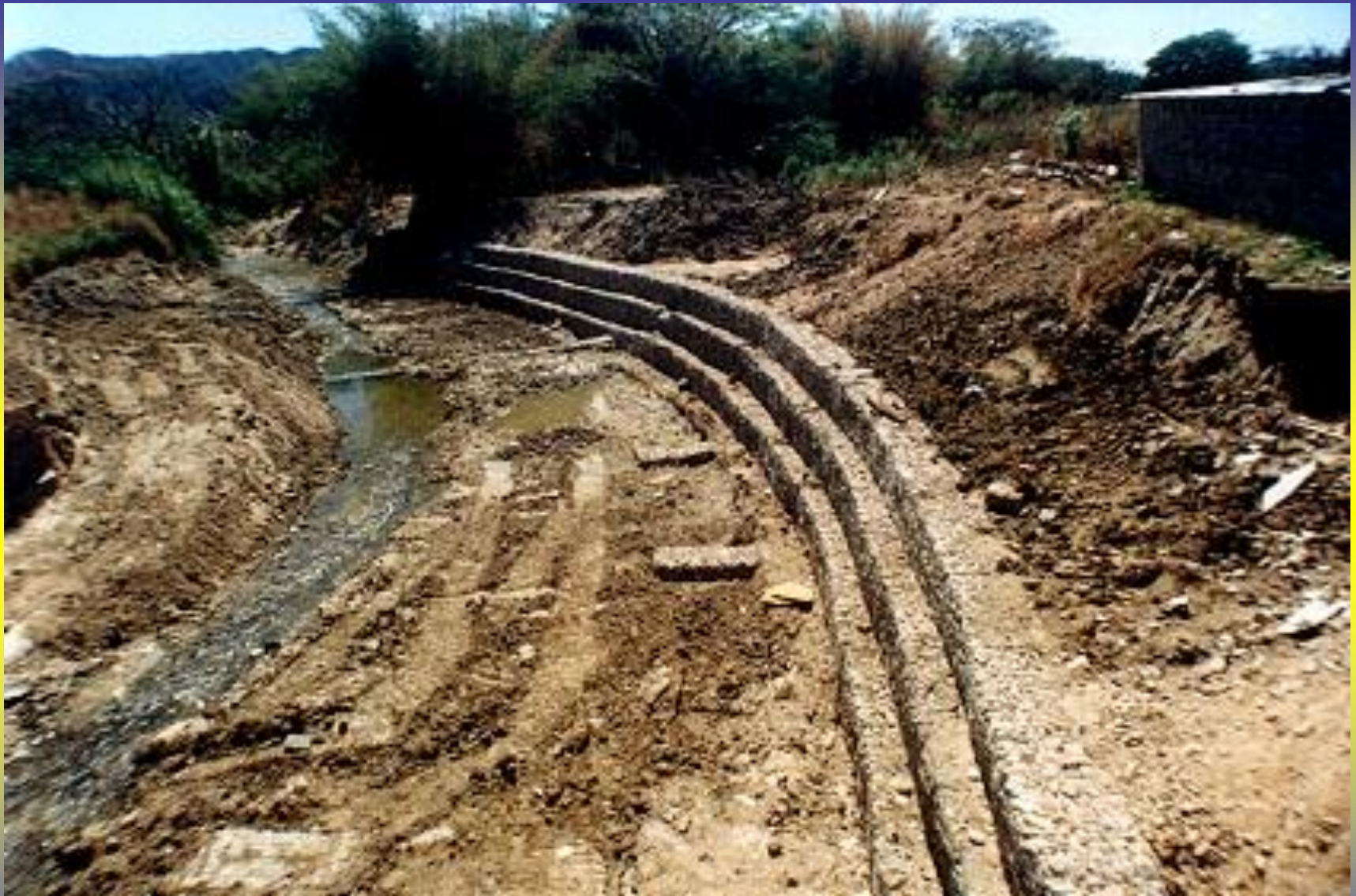
PROTECCION DE MARGENES, RIO CABRIALES, VALENCIA, ESTADO CARABOBO.
