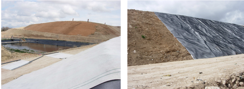
Figura 35. Sellado del antiguo vertedero de alta densidad
