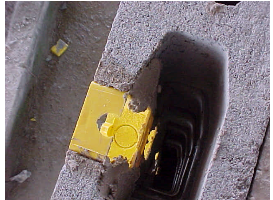
Aplicação da caixa elétrica
