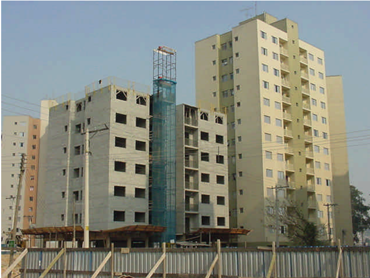
Residencial Vida Nova – Construtora Noroeste Osasco - SP
