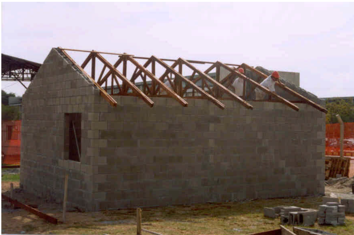
Execução da cobertura
