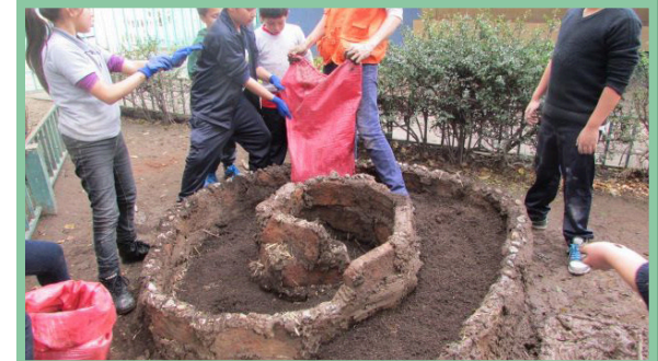
Fig. 44 Rellenado con tierra
