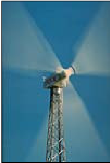
Fig. 5.14. Torre de celosía [1]
