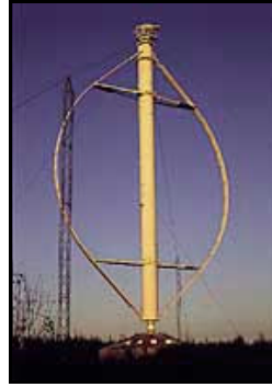
Fig. 3.6. Aerogenerador de eje vertical [1]
