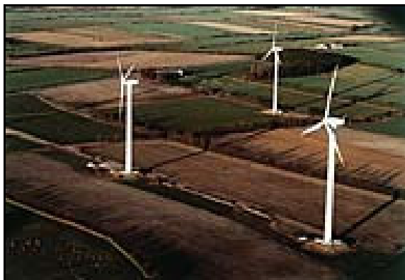
Fig. 5.13. Torres tubulares de acero [1]
