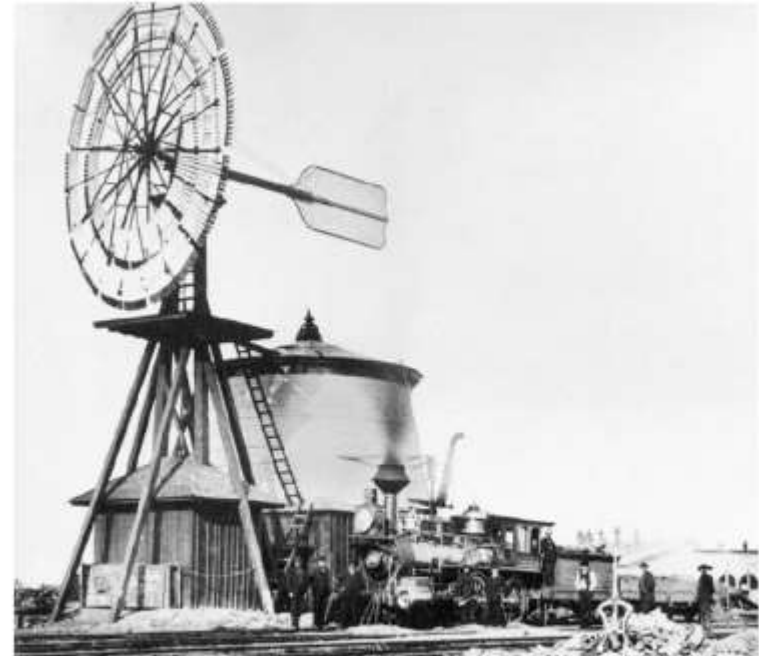
Figure 13: Recarga de agua para Union Pacific Railroad.
