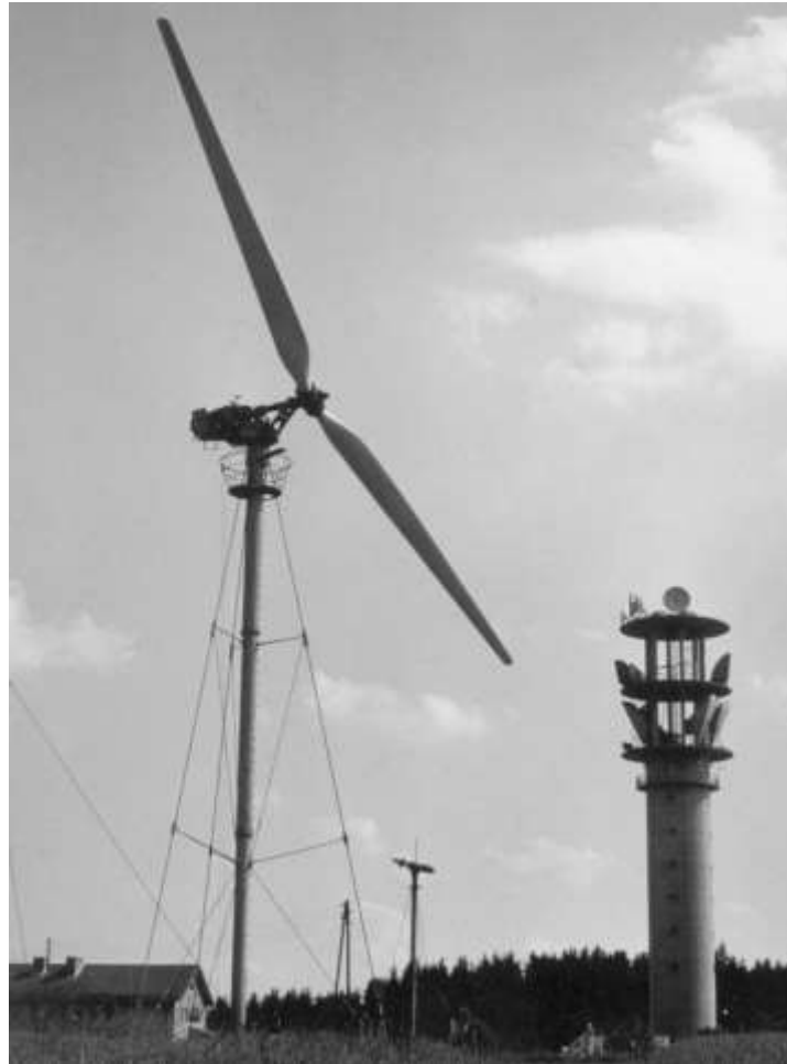
Figure 19: Aerogenerador W-34 construido por U. Hütter en Stötten, Alemania (diámetro del rotor 34 m, potencia 100 kW), 1959–1968.
