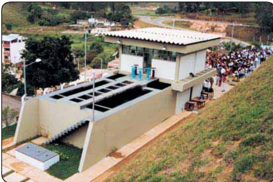
Foto 2 — Estação de tratamento de água convencional — capacidade 5l/s São Pedro do Avai - Manhuaçu/MG
