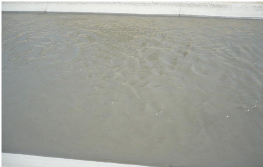
Fig. N° 67 Se observa el flujo permanente en el canal Chimbote.
