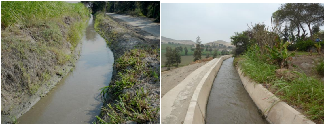
Fig. N° 65 en la imagen se observa canal revestido y no revestido.
