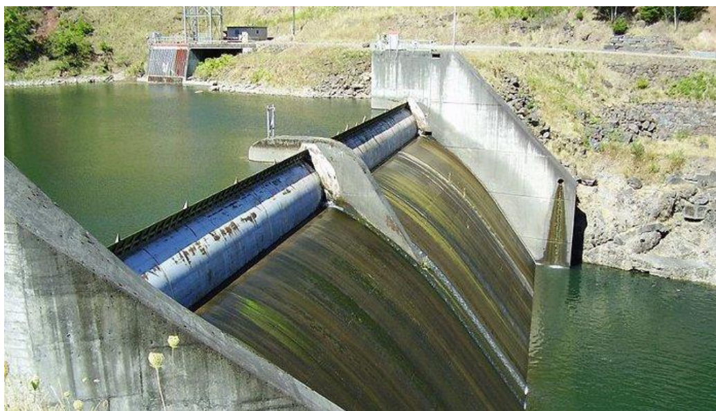
Fig. N° 37 Se observa el barraje fijo en una bocatoma.
