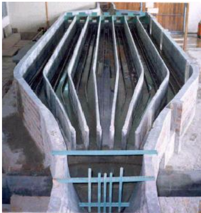
Fig. N° 59 Se observa la operación de la purga de sedimentos en un desarenador.
