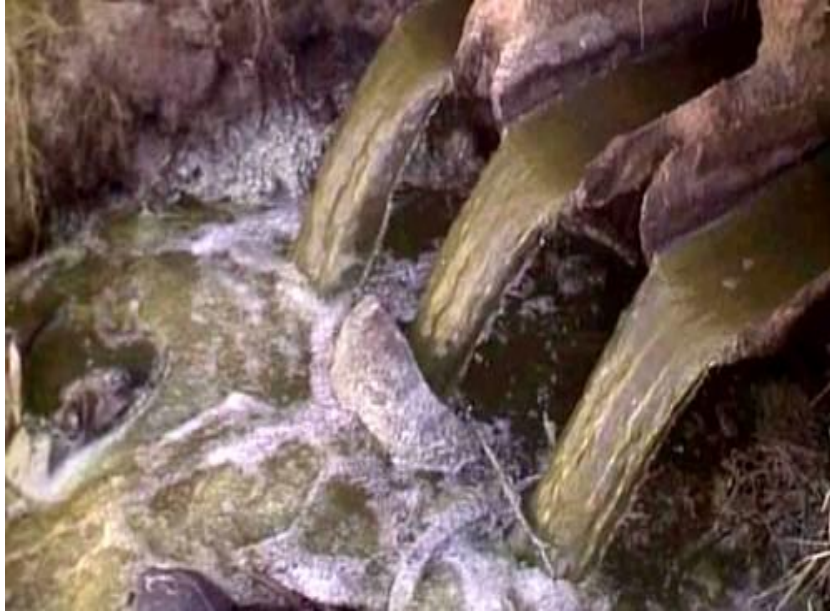
Fig. N° 09 Se observa el arroyo de las aguas contaminadas al río.
