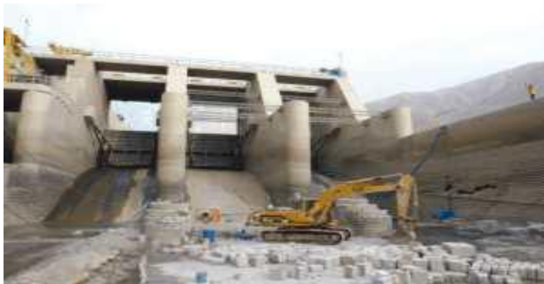
Fig. N° 40 Se observa el mantenimiento en la bocatoma del PE Chavimochic, en épocas de estiaje.
