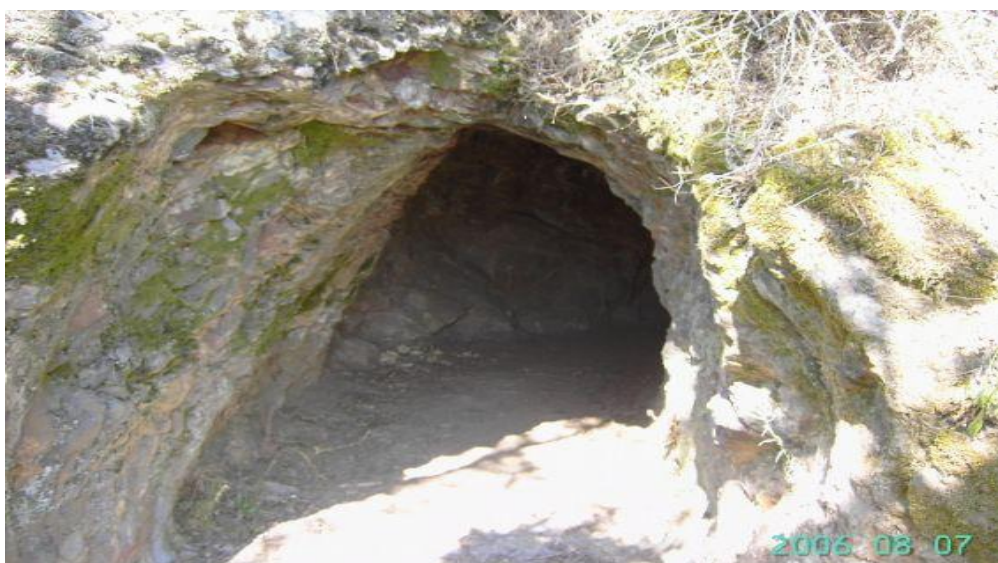
Fig. N° 64 en la imagen se observa un túnel para la conducción de las aguas del Río Mala..
