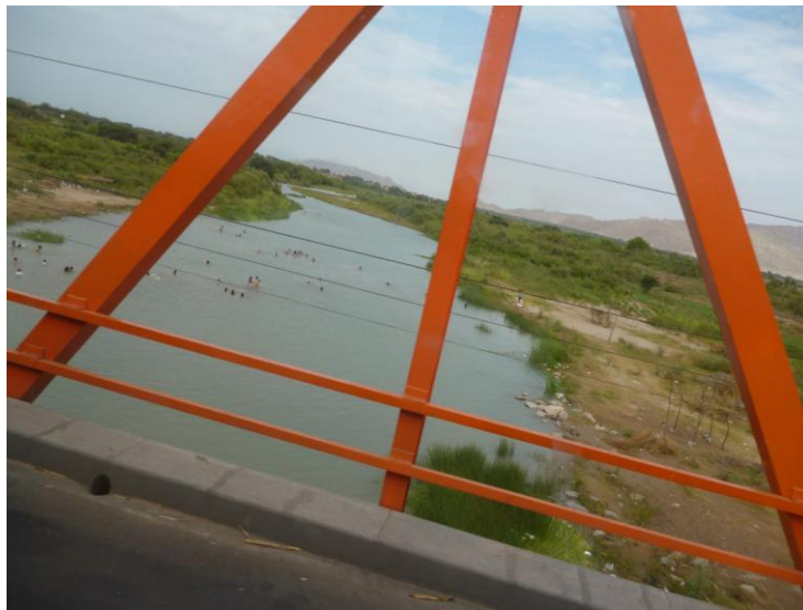
Fig. N°03 Se observa el rio antes de pasar el puente Reque.
