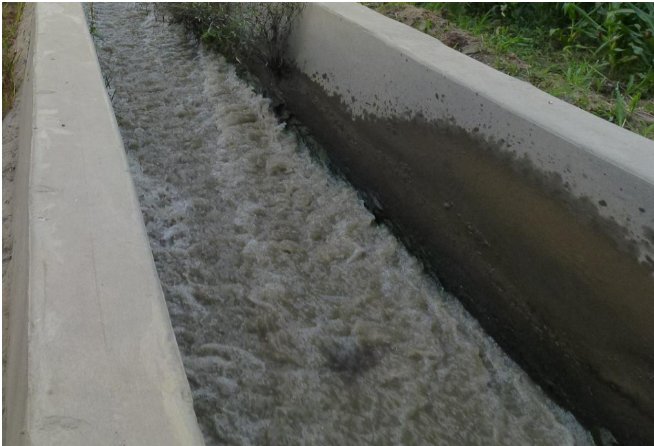
Fig. N° 68 se observa el flujo de agua con la presencia de trenes de onda.
