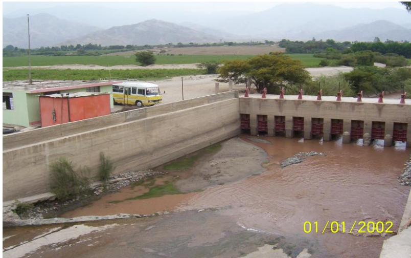
Fig. N° 12 Se observa la captación de la bocatoma la Achirana- ICA.
