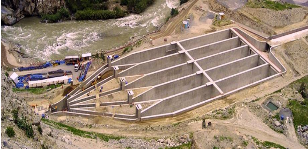
Fig. N° 50 se observa un desarenador de cinco naves.
