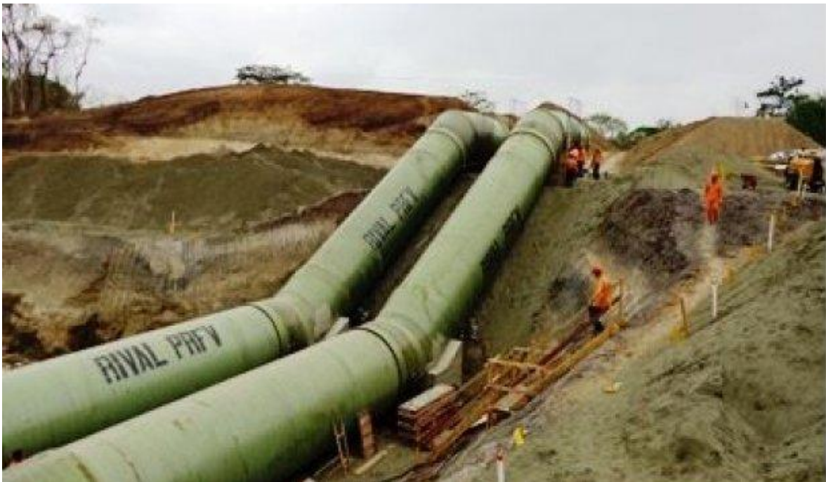
Fig. N° 101 se muestra un sifón invertido
