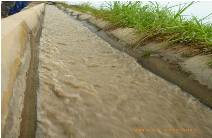
Fig. N° 69 Se observa el flujo de agua con la presencia de trenes de onda.
