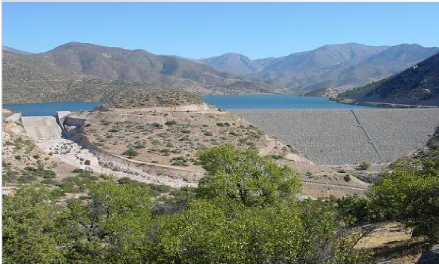
Fig. N° 17 Se observa el embalse de las aguas, para las épocas de estiaje.
