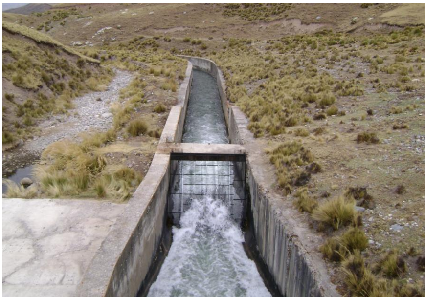
Fig. N° 19 Se observa el canal de salida de las aguas del embalse de Marcapomacha.
