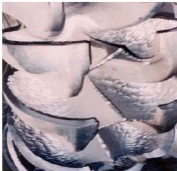
Fig. N°.55 Se observa el desgaste producido por las características altamente abrasivas de los sólidos en suspensión, Alabes de la turbina pelton de la central hidroeléctrica del cañón del pato.
