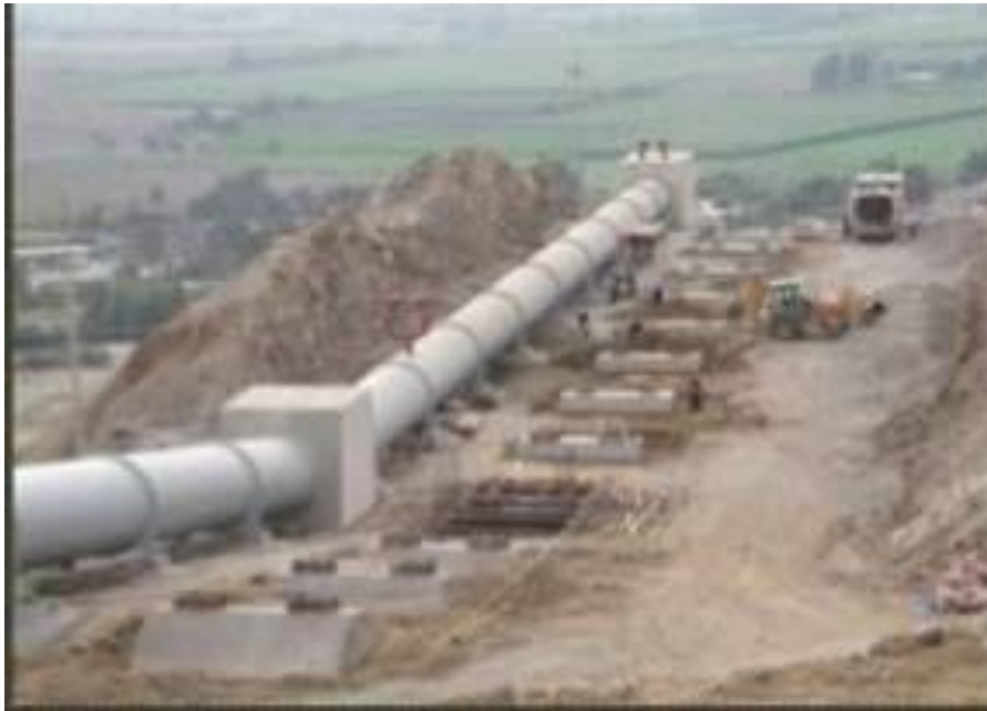
Fig. N°95 se muestra un sifón invertido.
