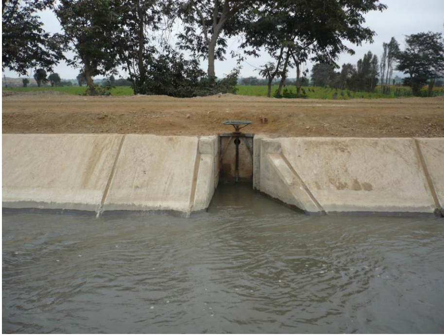
Fig. N° 76 Se observa la captación del agua en el canal Chimbote.
