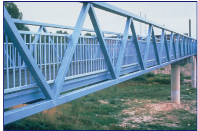
T2c56 Pasarela utilizando celosías sobre tablero
