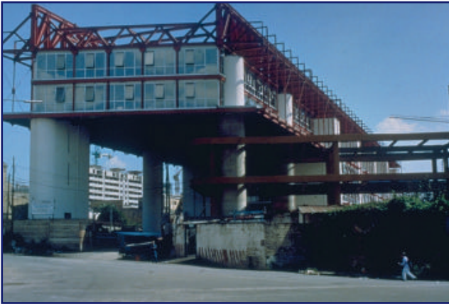
T2c38 Estación de bomberos, Nápoles, Italia
