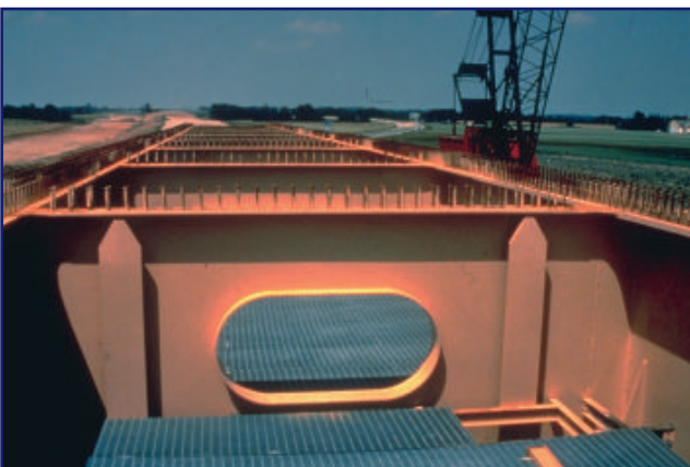
T2c106 Vigas transversales
