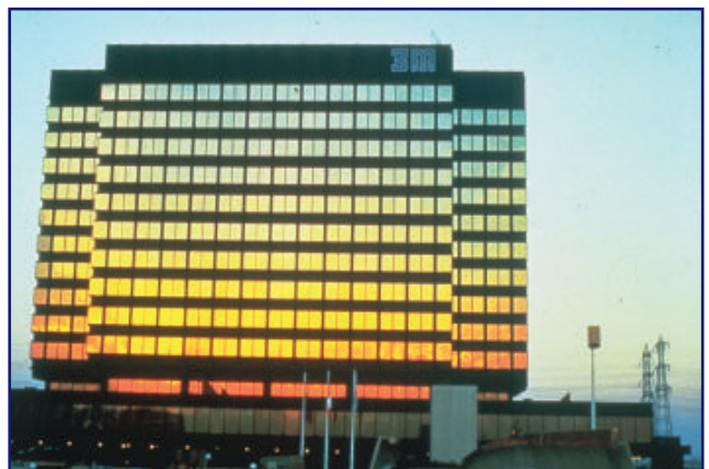
T2c141 Oficinas de 3M, Cergy-Pontoise, Francia
