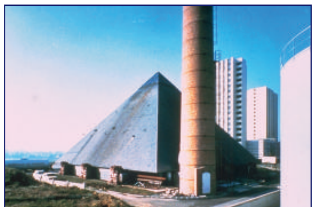
T2c36 Instalación térmica, Mons en Bareuil, Francia
