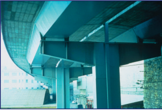
T2c102 Apoyos de puente
