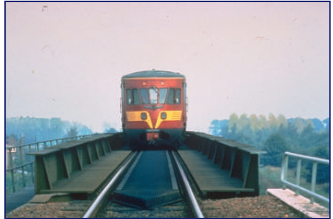
T2c54 Puente de ferrocarril de tablero continuo
