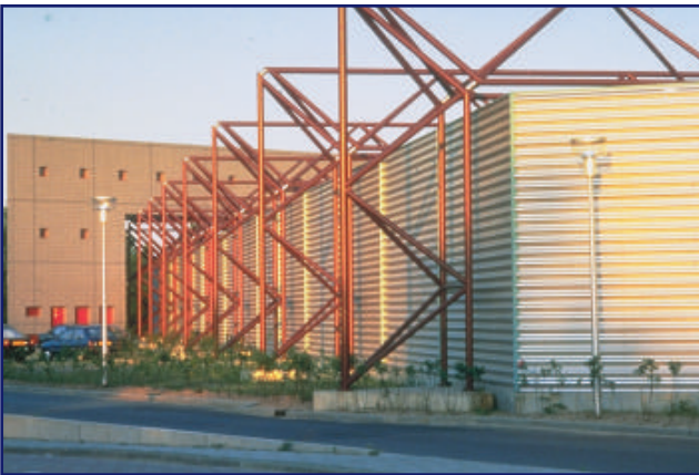
T2c33 Estación de Autobuses, Eindhoven, Holanda
