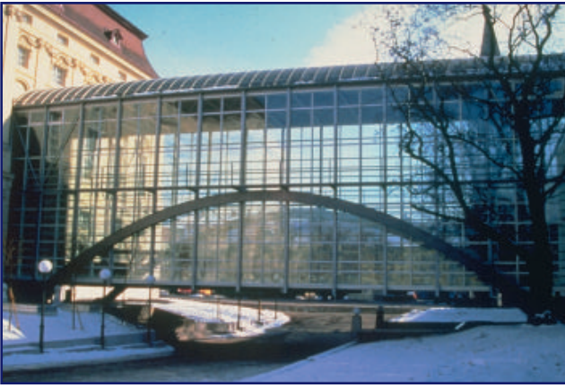
T2c59 Puente de unión en acero y vidrio
