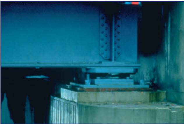
T2c99 Apoyos de puente
