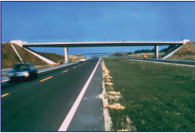
T2c51 Puente de vigas armadas en autopista, Normandía
