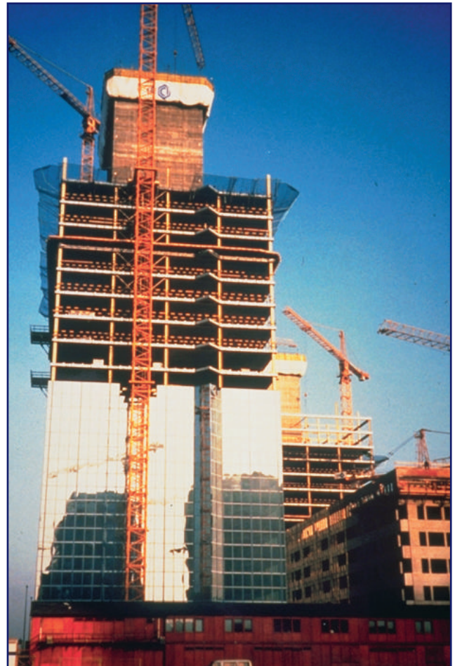
T2c129 Si se requieren núcleos rígidos se utilizan las escaleras o cajas de ascensores
