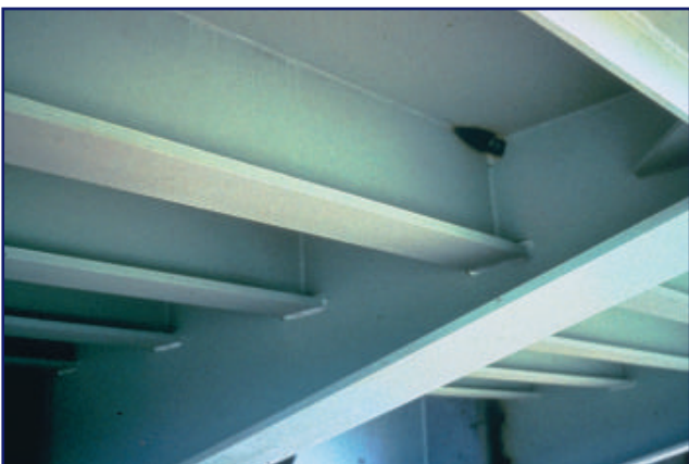
T2c111 Detalle de vigas longitudinales y transversales
