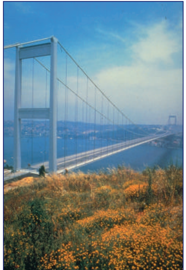
T2c95 Puente sobre el Bósforo
