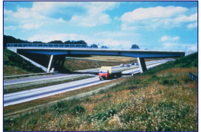
T2c62 Puente de vano simple y ménsulas laterales
