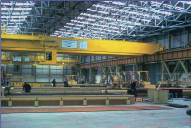
T2c13 Taller con puente grúa
