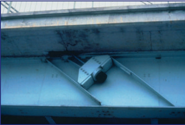
T2c103 Unión de anclaje a viga rigidizada
