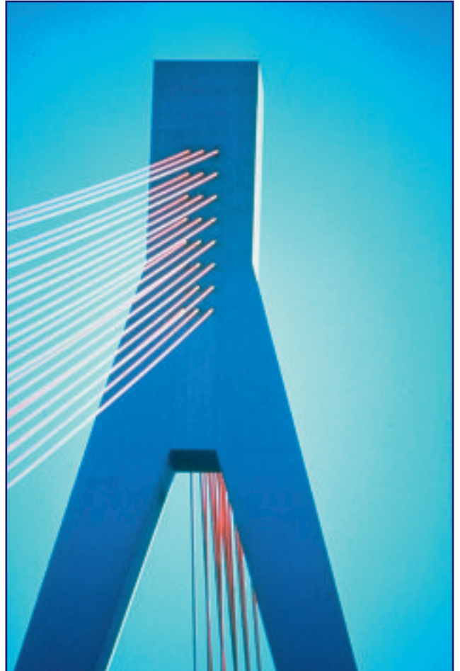
T2c107 Detalle anclajes pasantes, Speier (Rhin), Alemania
