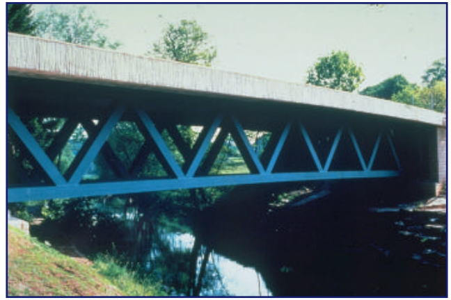
T2c52 Puente de vigas en celosía
