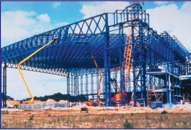
T2c17 Ejemplo de estructura espacial durante el montaje. Val de Marne, Francia
