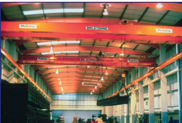
T2c7 Estructura de pórticos simples finalizada
