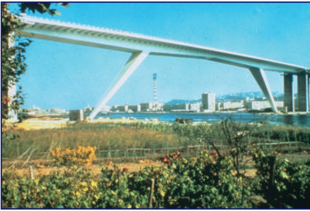
T2c67 Viaducto de Martigues
