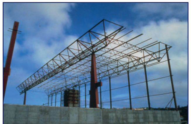
T2c8 Estructura de pórticos simples durante el montaje
