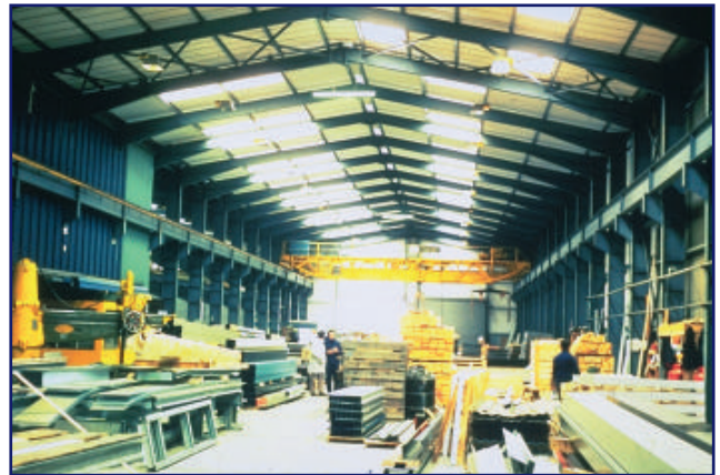
T2c12 Taller con puente grúa
