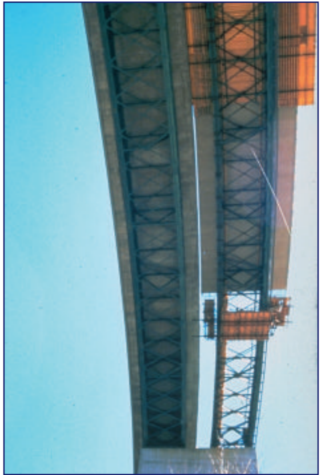
T2c110 Ensanchamiento de puente (puente antiguo a la izquierda, nuevo a la derecha)
