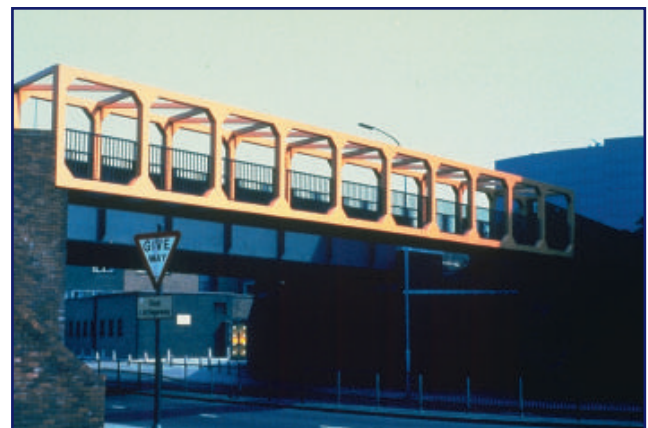
T2c58 Pasarela utilizando vigas virendel sobre tablero
