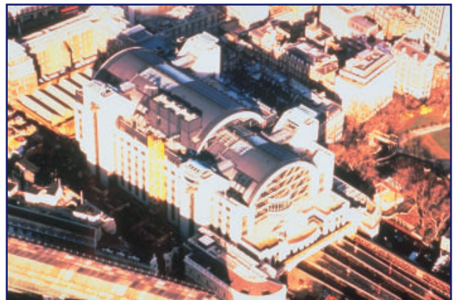
T2c159 Embankment Place, Londres, Reino Unido
