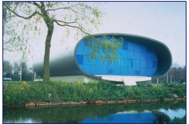
T2c34 Estación elevadora, Rotterdam, Holanda
