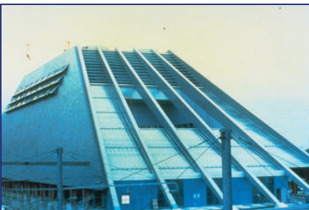
T2c35 Instalación térmica, La Defense, Paris, Francia
