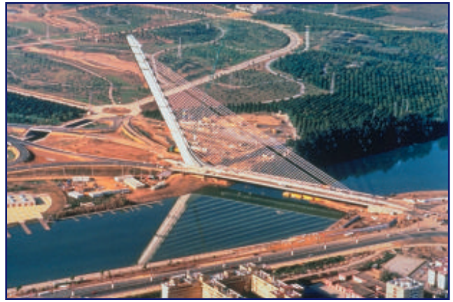
T2c82 Puente del Alamillo, Sevilla, España
