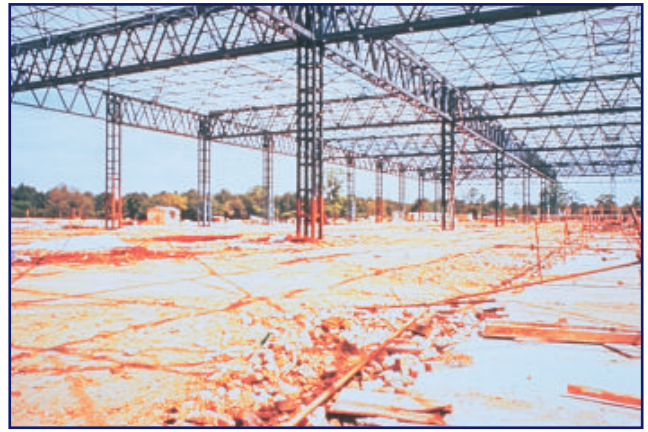
T2c10 Montaje de estructura espacial
