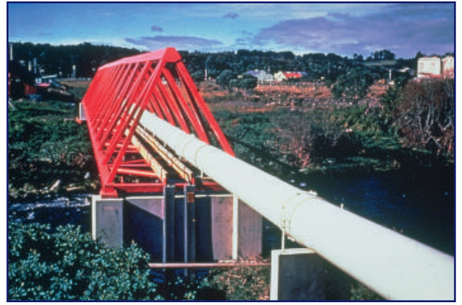
T2c60 Puente de celosía triangular para oleoducto
