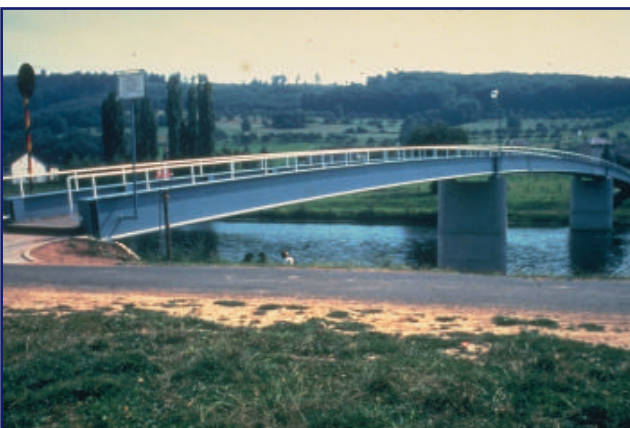
T2c49 Construcción de pasarela peatonal
