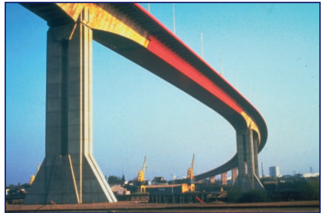
T2c66 Puente Chevre sobre el Loira en Nantes, Francia (1992)
