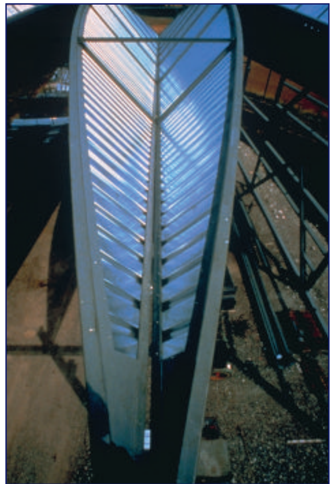
T2c23 Nave almacén Jakem, Munchwilen, Aargau, Suiza
