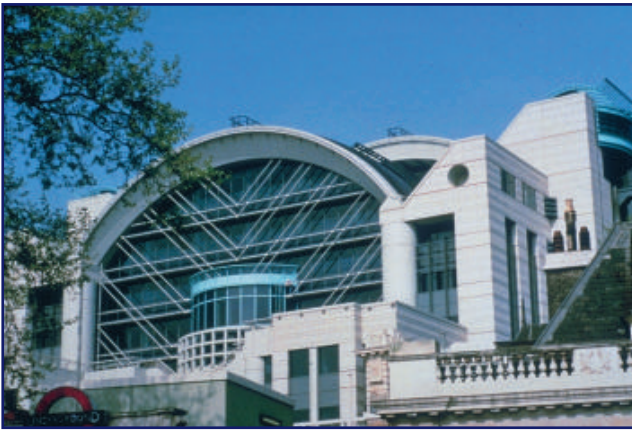
T2c160 Embankment Place, Londres, Reino Unido
