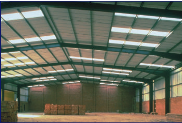
T2c3 Vista interior de estructura de pórtico finalizada
