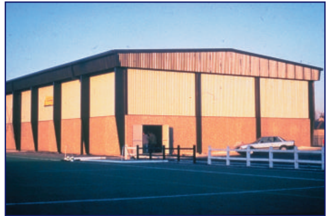
T2c4 Estructura de pórtico simple
