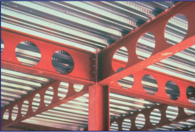
T2c117 Vigas con agujeros circulares también permiten paso de instalaciones
