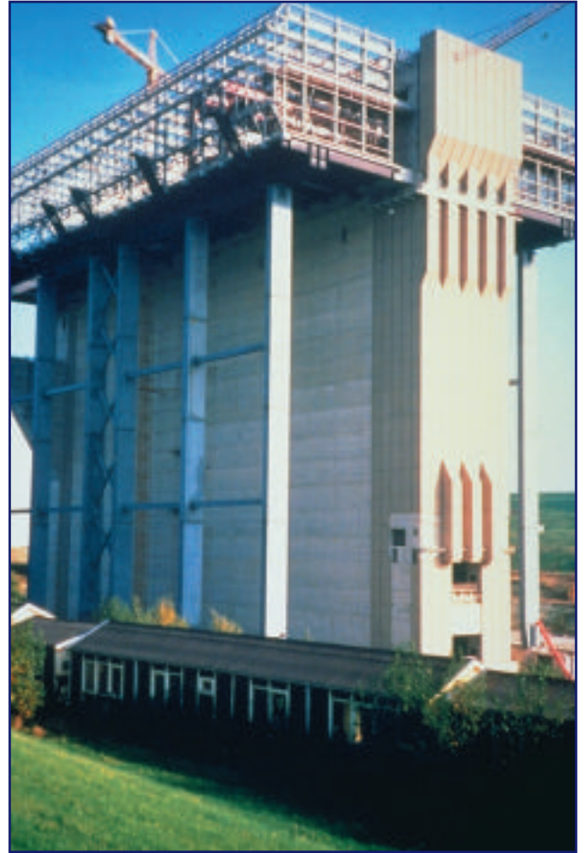
T2c32 Canal del Centro, ascensor en Strey-Thieu, Bélgica
