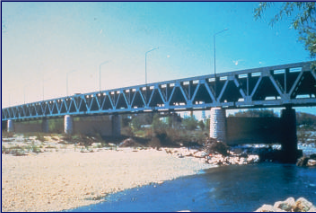
T2c53 Puente de celosía en Cavillon, Francia
