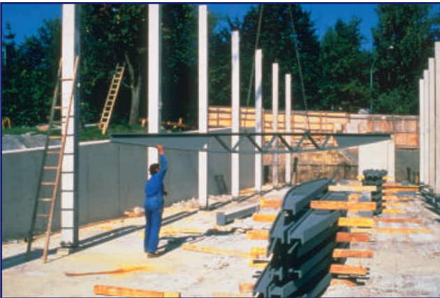
T2c119 Montaje de celosías sobre pilares compuestos
