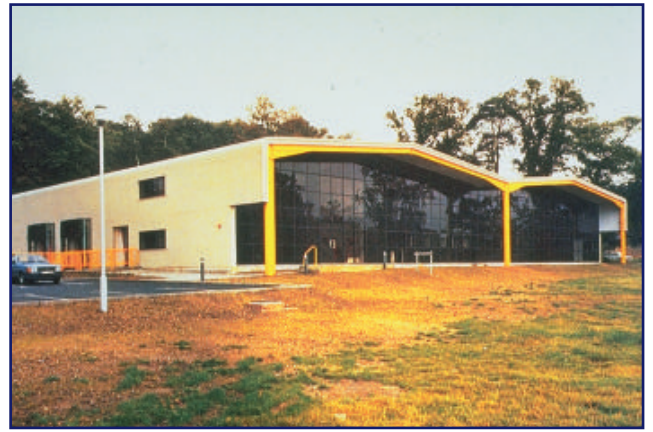
T2c2 Vista exterior de estructura de pórtico finalizada
