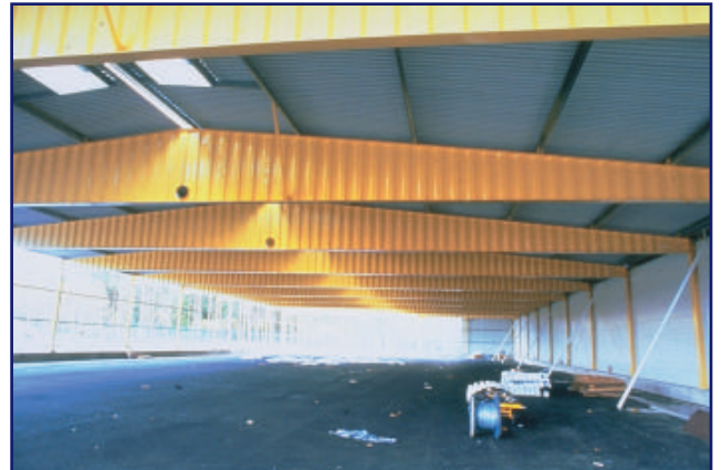
T2c6 Estructura de pórticos simples finalizada
