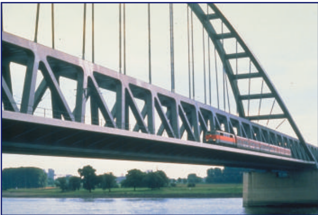
T2c85 Puente de ferrocarril (totalmente soldado), Dusseldorf, Alemania
