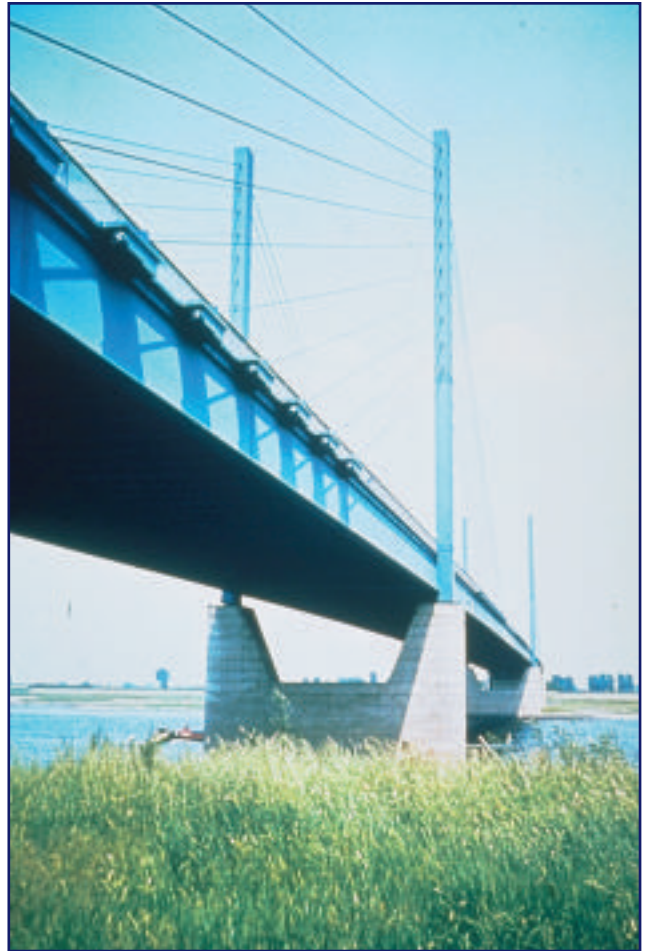
T2c77 Puente atirantado, Rees, Alemania
