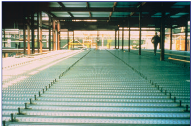
T2c114 Vista interior, estructura mixta
