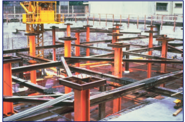
T2c126 Forjado integrado con pilares con capitel
