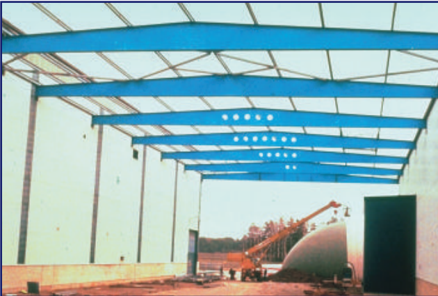
T2c5 Pórticos simples en ejecución
