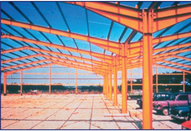
T2c1 Estructura de pórtico durante el montaje
