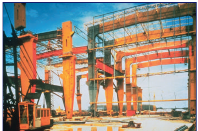
T2c16 Instalaciones fabriles, Chalons sur Soane, Francia
