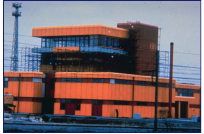
T2c18 Torre de control de los ferrocarriles belgas. Antwerp, Bélgica
