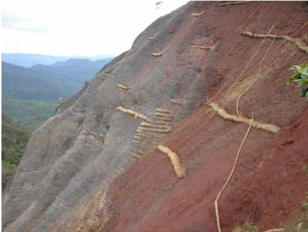
**Foto 1:** Cierre de mina: tratamiento de laderas con las técnicas de Bioingeniería de Suelos.
