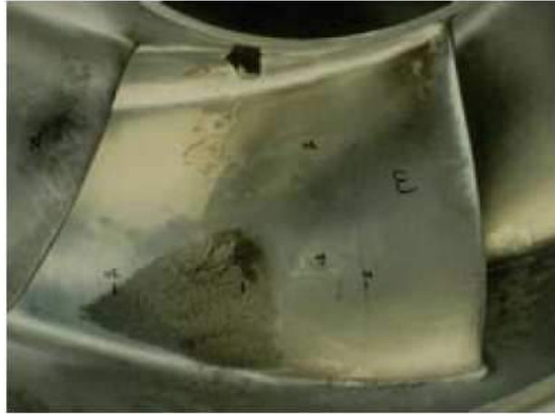
Figura 50: Álabes deteriorados debido a la cavitación
