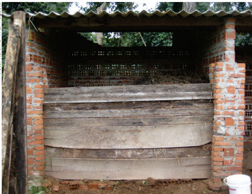
Figura 5. Baia de compostagem de mortalidade
