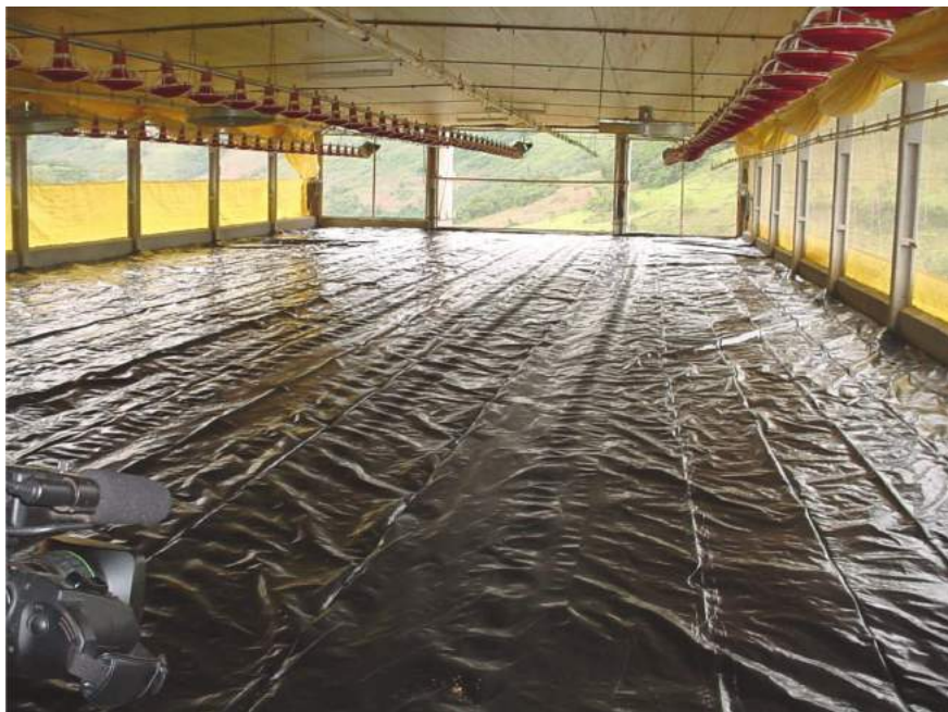
Figura 2. Cobertura com lona no aviário (fermentação plana)
