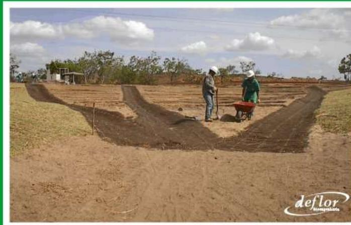
Construção de drenagem superficial com biotêxtil, mostrando a retenção de sedimentos e eficiência na drenagem.
