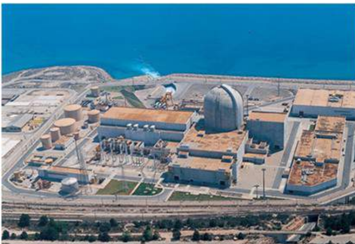
La central nuclear – Vandellós II.
