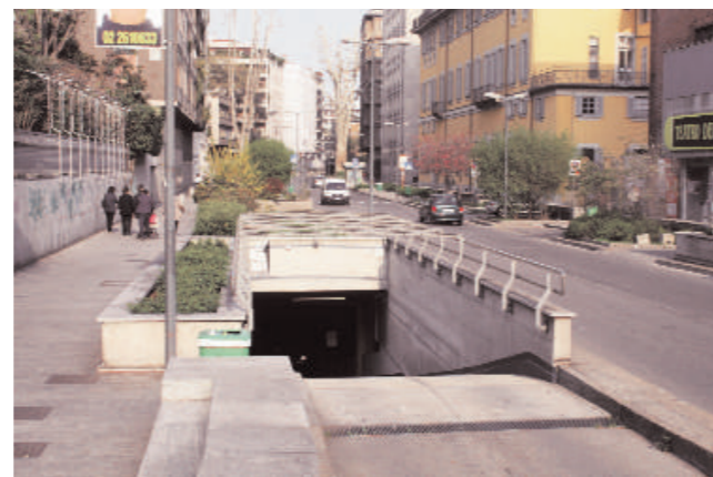
Las rampas de este estacionamiento subterráneo están bien integradas con la acera grande
