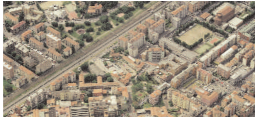
La línea del metro, cerca de una vía de circulación rápida, produce una fuerte barrera física que divide el barrio
