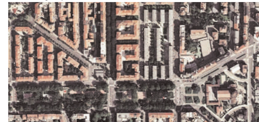
Este plano de vivienda pública construido en los años '50 se integra muy bien en el entorno urbano
