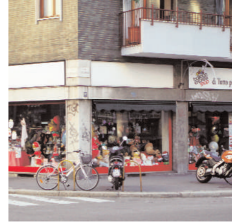
Las tiendas ubicadas en la planta baja, en las esquinas de las calles incrementan considerablemente el control espontáneo
