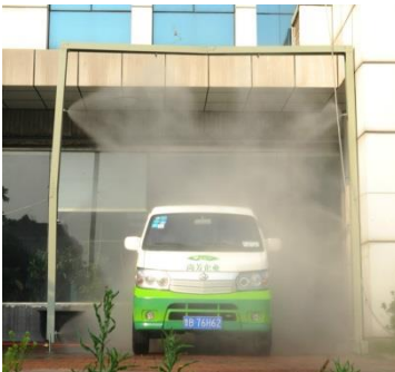
Figura 6: Arco de desinfección al ingreso de la Granja.
