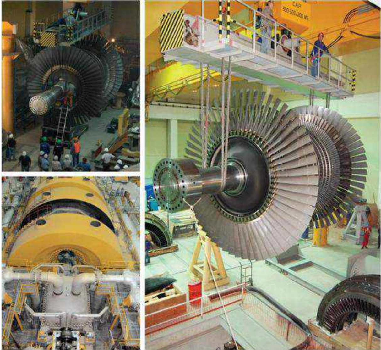
Figura N°10: Montaje del turbogruppo de Atucha II
