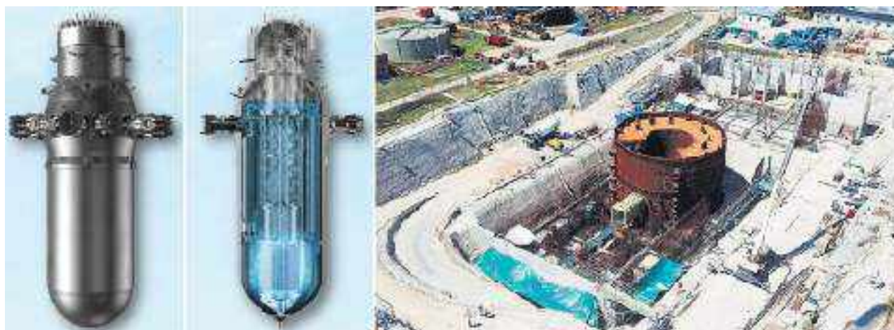
Figura N°18: Núcleo del reactor CAREM (izq.) – avance de obra a julio de 2019 (der.)
