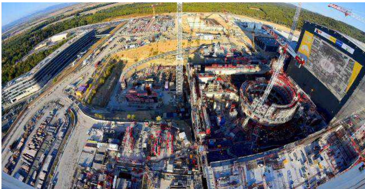
Figura N°20: Proyecto ITER – avance de obra a abril de 2019
