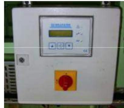
*Fig.13 Panel de control del lavado del filtro.*
