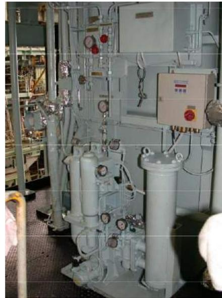
*Fig.11 Filtro automático de las bombas de control*
