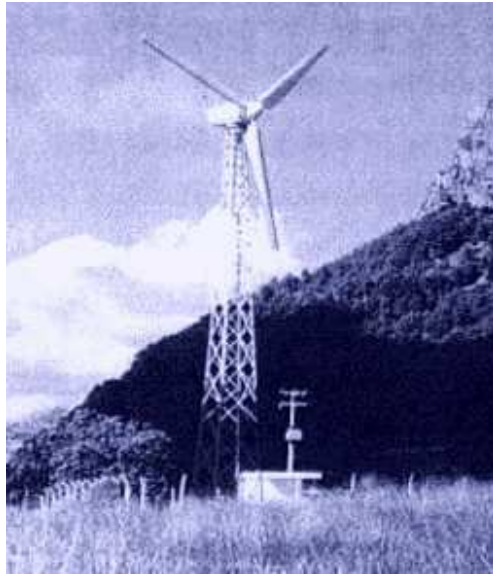
Figura 4.7 - Turbina de eixo horizontal tripá com gerador de 75KW. [12]
