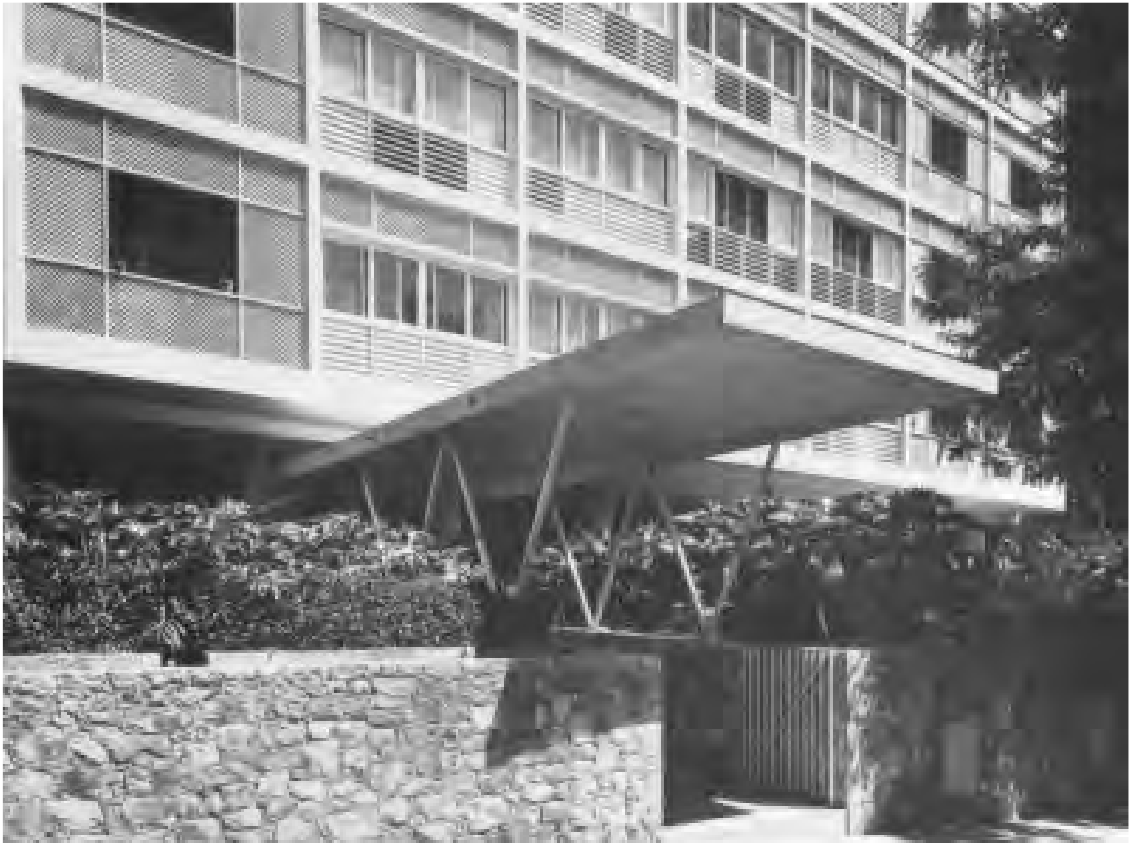
Figura 13: Edifício Antonio Ceppas.
