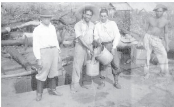
Figura 4 - Homens com baldes provavelmente retirando água do poço
