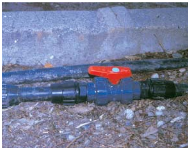
Figura 13. Válvula de esfera.
