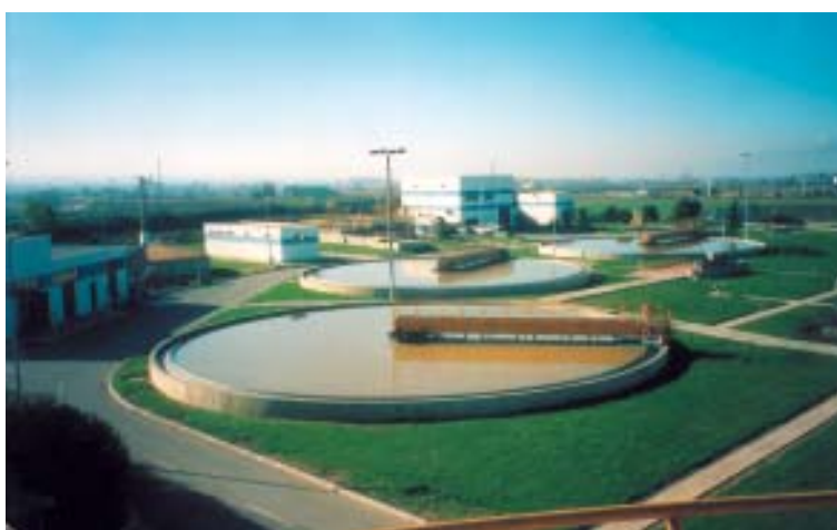
Figura 7. Vista general de la Estación Depuradora de Aguas Residuales de Granada.
