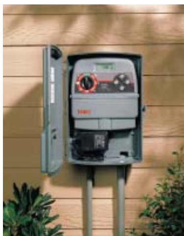
Figura 7. Los programadores suelen instalarse en el interior o a la intemperie, en una caja.
