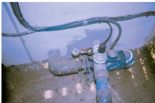
Figura 10. Bomba de eje horizontal.
