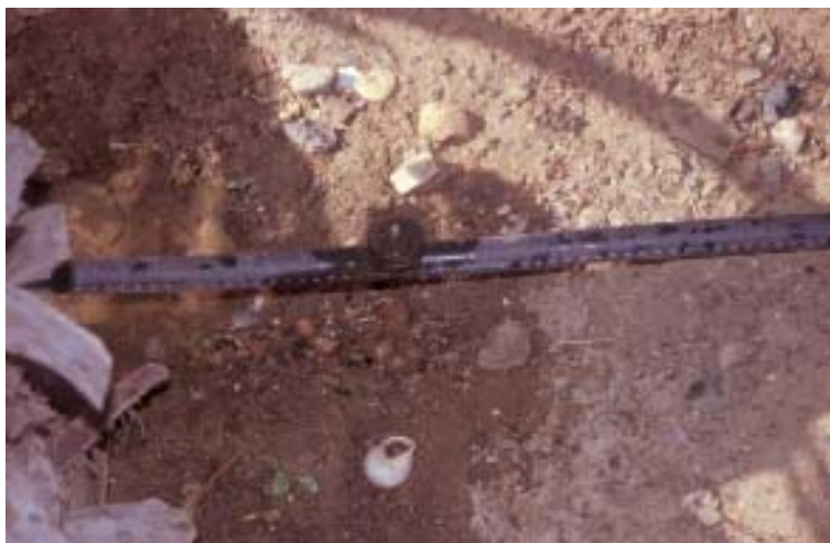
Figura 6. La colocación de los goteros en una posición correcta, previene de posibles obturaciones internas en los mismos.
