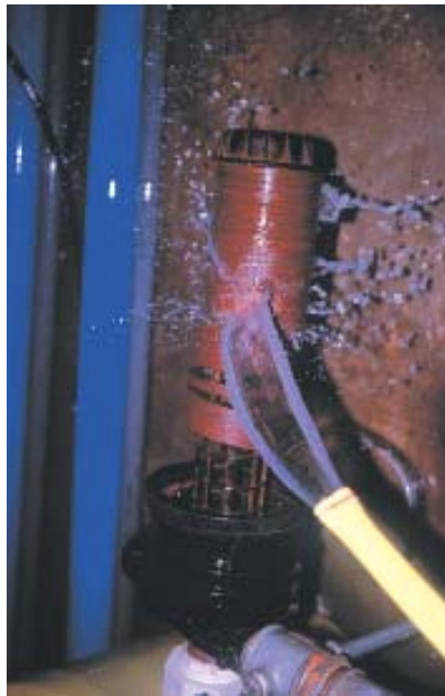
Figura 8. Limpieza manual de un filtro de anillas.
