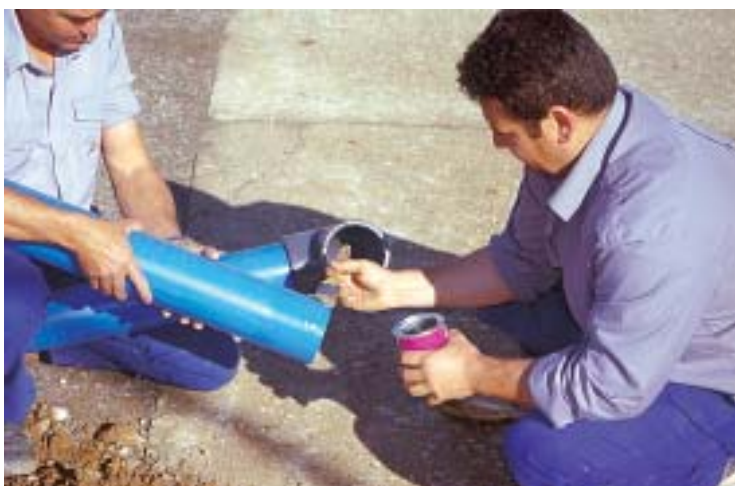
Figura 11. Encolado de un codo a una tubería de PVC.
