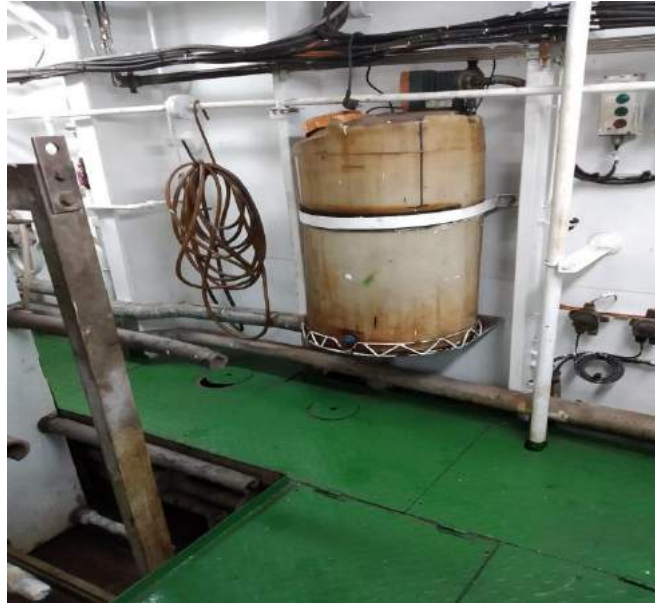
Ilustración 12: Tanque de dosificación química. Elaboración propia.
