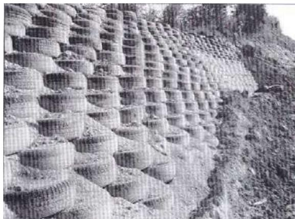
FIG 5.8 - Proteção Direta – Sistema Eco-Estrutural Pneumático – Muro de
