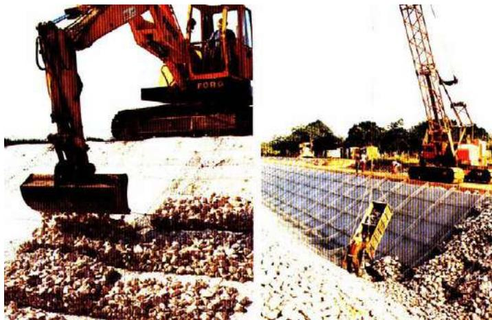
FIG 5.5 - Proteção Direta – Colchão Reno – Enchimento do colchão Reno na obra
