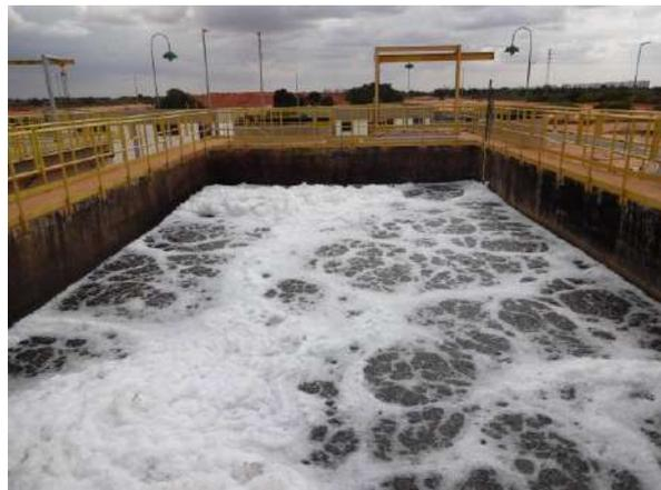
Por intermédio da recirculação e do descarte dos sólidos retirados dos decantadores secundários, a biomassa dispersa de lodo ativado é controlada para que a população de microorganismos ativos no interior do reator seja mantida em concentração adequada, de modo a permitir que se atinja as eficiências de projeto, tanto em relação a remoção de matéria carbonácea, quanto no tocante ao nível de nitrificação necessário.
