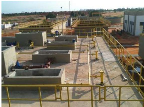
O afluente proveniente da caixa de repartição de esgoto desarenado, por intermédio de tubulações de 300 mm, chega pela parte superior do UASB e é lançado em caixas de distribuição, de onde partem os tubos de descida que se estendem até um ponto próximo ao
