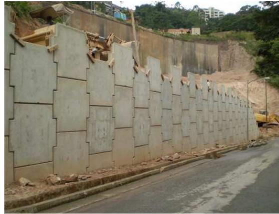
(b) Muro gravitatorio de tierra armada
