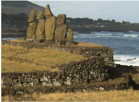
(a) Muro gravitatorio de albañilería de piedra
