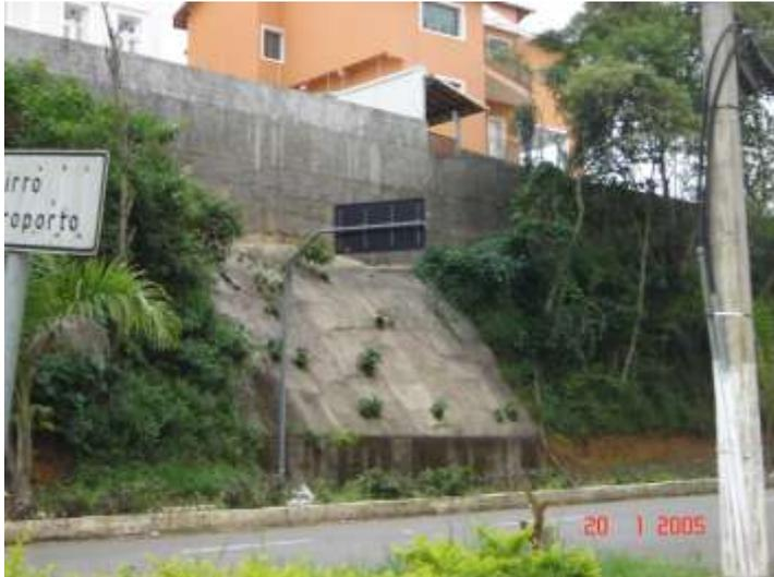
Figura 07 – Exemplo de talude natural **instável**, em que foram executadas obras (muro de arrimo de “pé” e proteção com tela argamassada) para a garantia de sua estabilidade.
