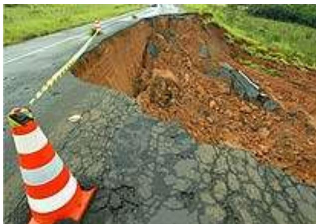
Figura 17 – Exemplo de trecho de estrada em aterro, implantada a vários anos, em que se configurou situação de variação do FS em época de chuvas, por infiltração de água através do pavimento trincado (Estado de São Paulo, janeiro de 2007 - UOL)
