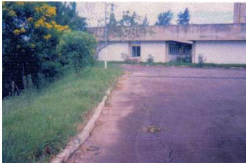
*Vista Superior CPD (UFJF): aterro – aparecimento de trincas no pavimento,*
