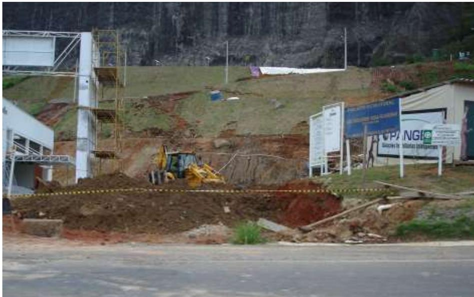
Figura 01 - Exemplo de obra em que se verificou uma série de escorregamentos de taludes, recentemente construídos, exigindo a re-adequação dos mesmos, a partir de novas obras.
