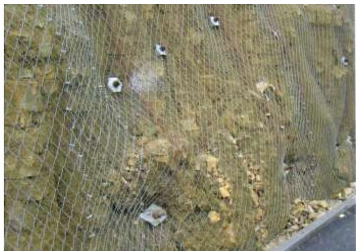
Figura 05 – Exemplos de talude em rocha, estabilizados com tela de arame de alta resistência.
