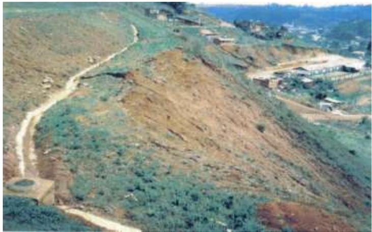
Figura 04 – Escorregamento superficial em extremidade de aterro mal compactado, seguido de processo de erosão.
