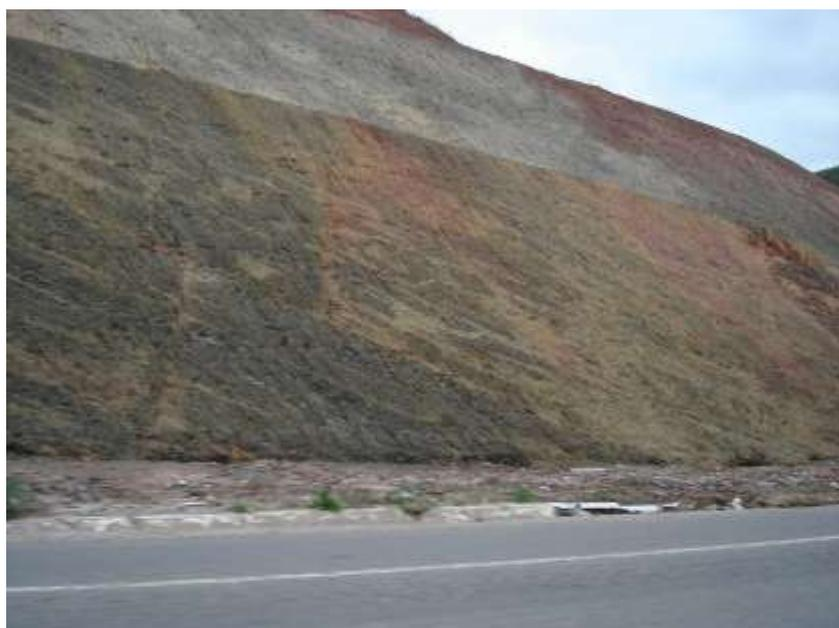
Figura 06 – Exemplo de talude natural (em corte) em que se pode observar a sua estrutura particular, associada à vida geológica do maciço, intimamente ligado, entre outras coisas, a ação do intemperismo (Av. Deusdeth Salgado – J. Fora/MG).
