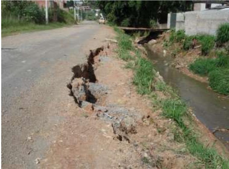
Figura 09 – Exemplo de talude artificial – ‘aterro’ rompido, na condição de coeficiente de segurança contra o escoramento inferior ao necessário para se garantir sua condição de estabilidade (Nova Era – J. Fora/MG, Agosto-2006).
