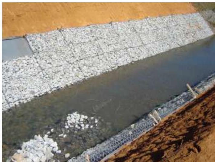
Figura 08 – Proteção de taludes de aterro em canal de curso d’água, com colchão de pedras de mão, contra o efeito de erosão desenvolvida pelo movimento da água no canal (São Pedro – J. Fora/MG, 2005).
