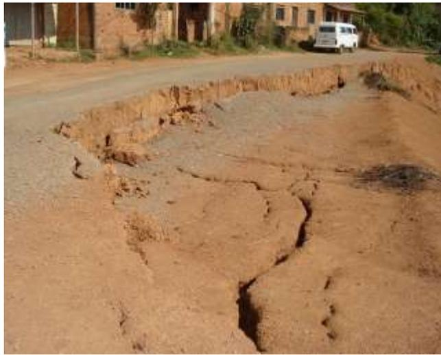
Figura 23 – Exemplo de talude de aterro “desmoronado”, após serem observados várias trincas de tração abertas no plano superior ao talude. Observe outras trincas, em paralelo, formadas na própria massa de solo deslocada (Santos Dumont/MG, Abril-2006).
