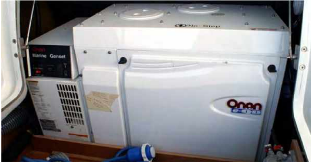
Figura 9-1; generador diesel marino de la casa Cummins Onan.
