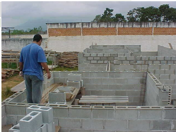
Figura 156 - Blocos assentados úmidos
