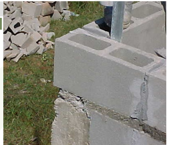
Figura 146 - parede com desaprumo
