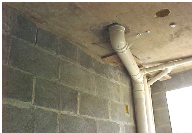
Figuras 104 - Exemplos de tubulações executadas segundo um projeto que respeita e outro que desrespeita as premissas apresentadas.
