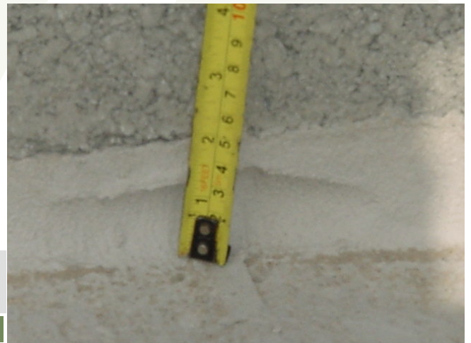
Figura 151- Espessura excessiva da junta, resultante de não nivelamento da laje
