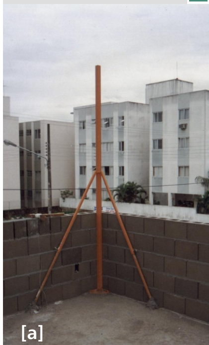
Figura 21 - a) Escantilhão. b) Nível alemão
