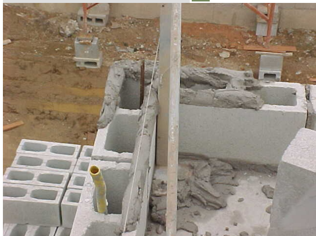
Figura 148 - Preenchimento errado de argamassa na junta
