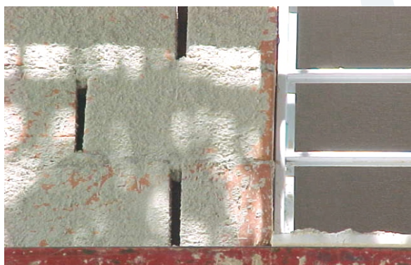
Figura 100 Parede executada com "junta seca".
