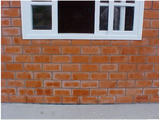
Figura 157 - Umidade ascendente do solo
