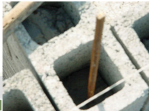
Figura 131 - Armadura centralizada no bloco
