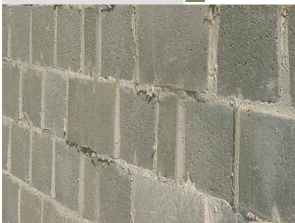
Figura 144- Uso de blocos irregulares
