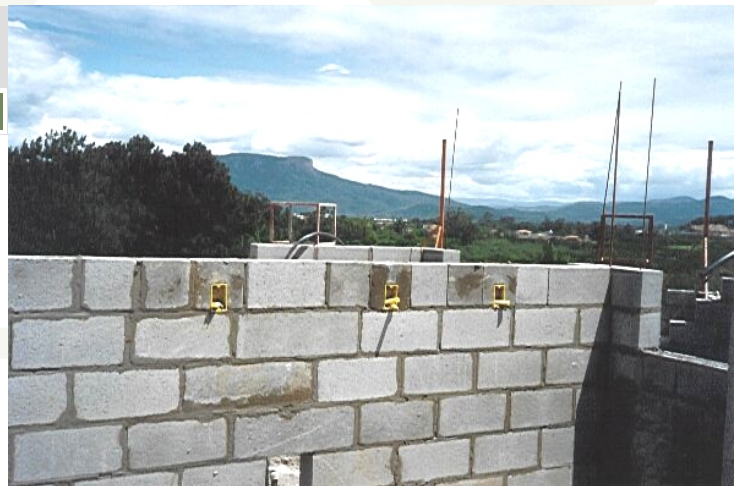
Figura 141 - Blocos com caixas colocados durante a elevação
