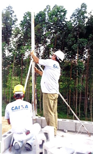
Figura 105 - Escantilhão metálico
