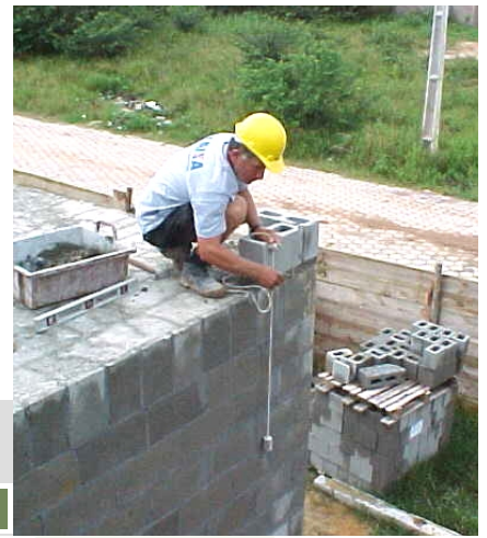
Figura 120 - Conferência de medidas do andar superior com o andar inferior
