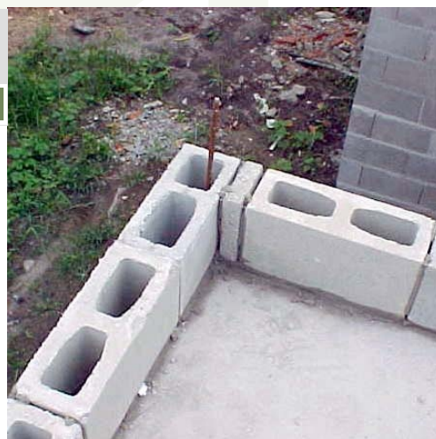
Figura 128 - Ajuste de modulação com colocação de bolacha no canto da parede
