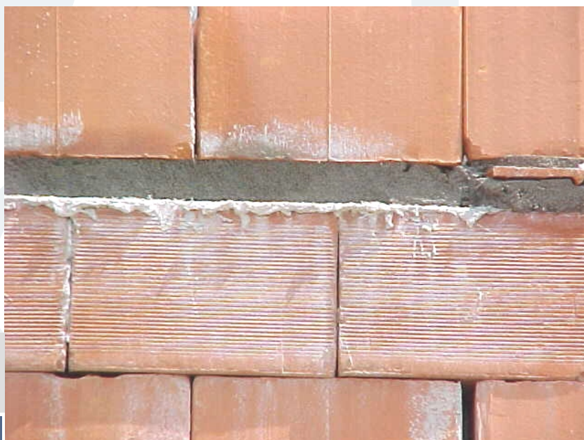
Figura 97 - Exemplo de mau uso de juntas horizontais e verticais, com espessuras muito variáveis
