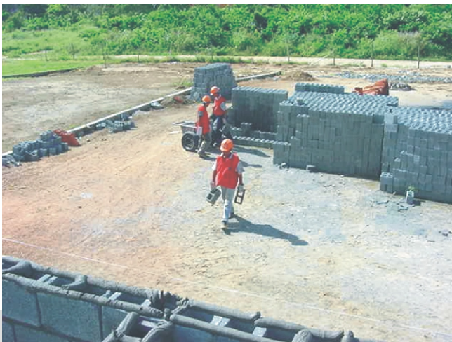
Figura 154 - Transporte não otimizado de blocos, resultante de inexistência de ferramenta adequada
