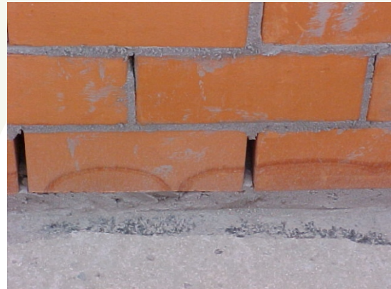
Figura 158 - Umidade ascendente do solo
