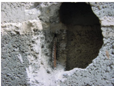
Figura 152 - Falha no grauteamento da parede
