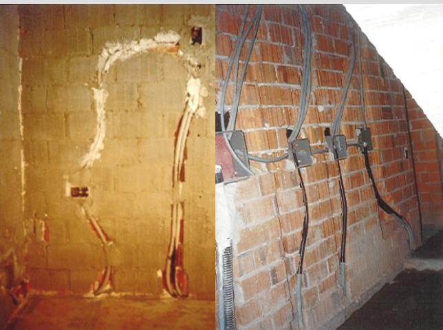
Figura 155 - Paredes com cortes para embutimento de instalações
