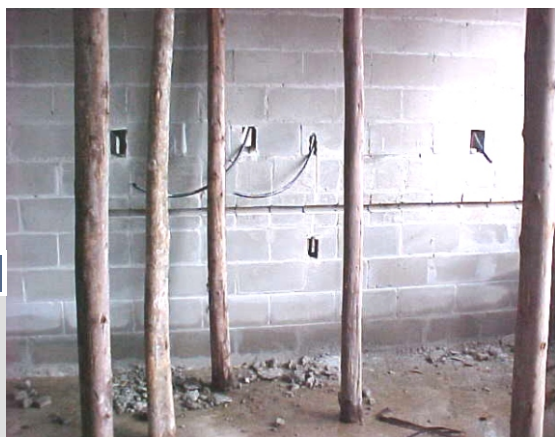
Figuras 105 - Exemplo de duto projetado erroneamente, que passa horizontalmente em parede estrutural.
