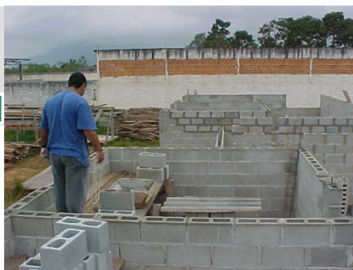
Figura 25 - O assentamento de blocos molhados causará o surgimento posterior de patologias nas paredes
