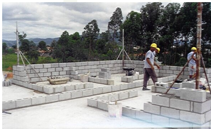
Figura 130 - Elevação dos castelos de alvenaria
