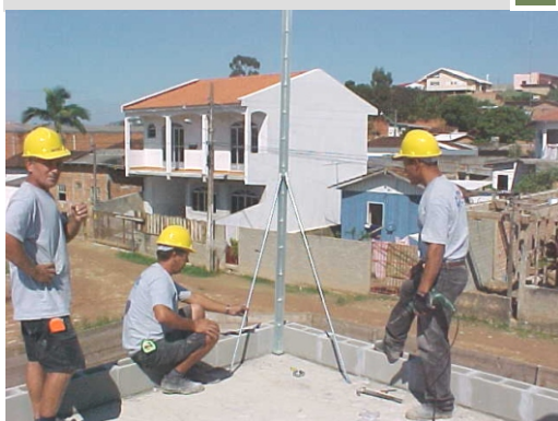
Figura 126 - Colocação do escantilhão
