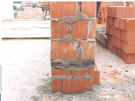
Figura 81 - Parede não detalhada resulta em improvisações com resultados indesejados
