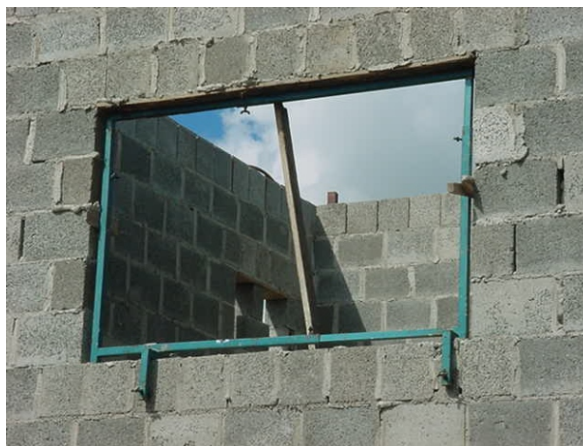
Figura 133 - Gabarito metálicos para vão de janela
