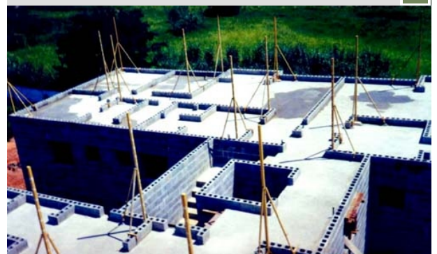
Figura 127 - Marcação da obra pronta com os escantilhões colocados
