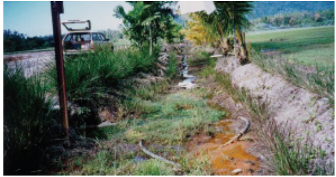
Uso del pasto Vetiver como protección de taludes en desagües.
