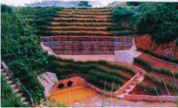
Uso del pasto Vetiver como protección de taludes en desagües.
