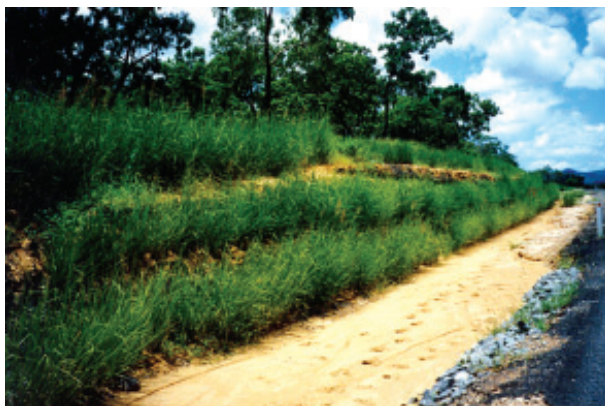
Uso del pasto Vetiver como protección de taludes en caminos.
