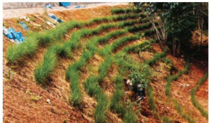
Uso del pasto Vetiver como protección de taludes en caminos.
