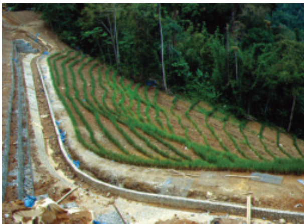
Uso del pasto Vetiver como protección de taludes en desagües.
