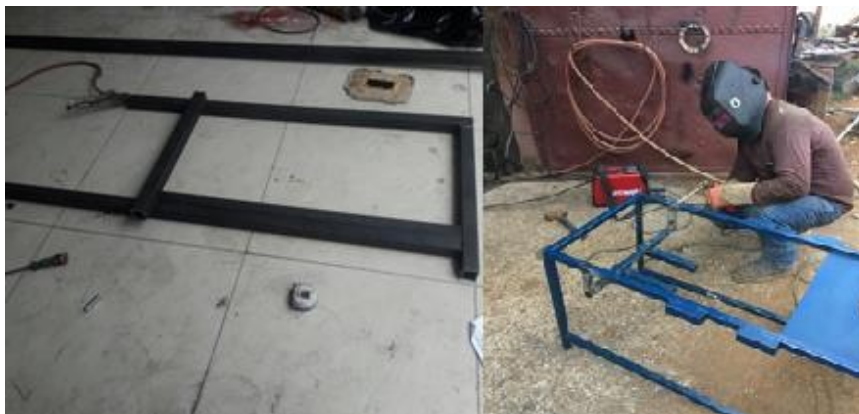
Figura 60. Construcción de un módulo estructural
