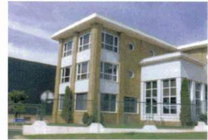
*Fig.12: Fachada edificio de oficinas resuelta con fábrica de ladrillo visto y revestimientos cerámicos.*
