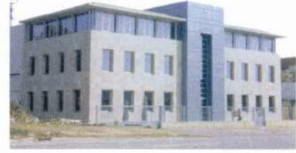
*Fig.11: Fachada edificio de oficinas resuelta con piedra natural, paneles metálicos lacados y vidrio.*
