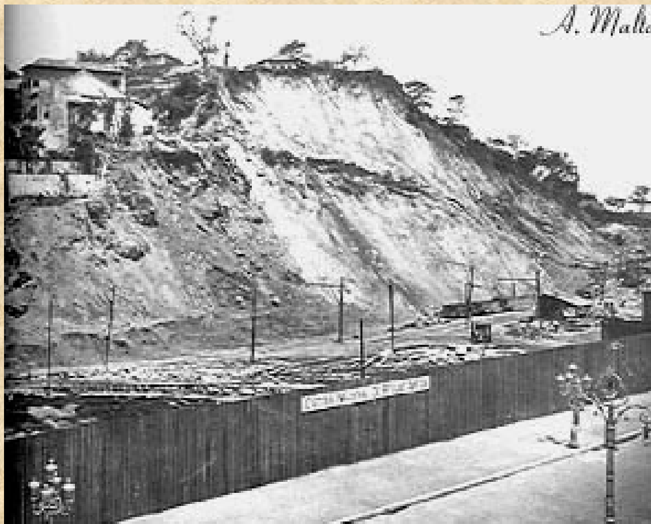
Demolição do Morro do Castelo, Rio de Janeiro. Augusto Malta.
