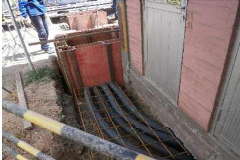
Figura 8 - Fôrma em chapa compensada para caixa de passagem.
