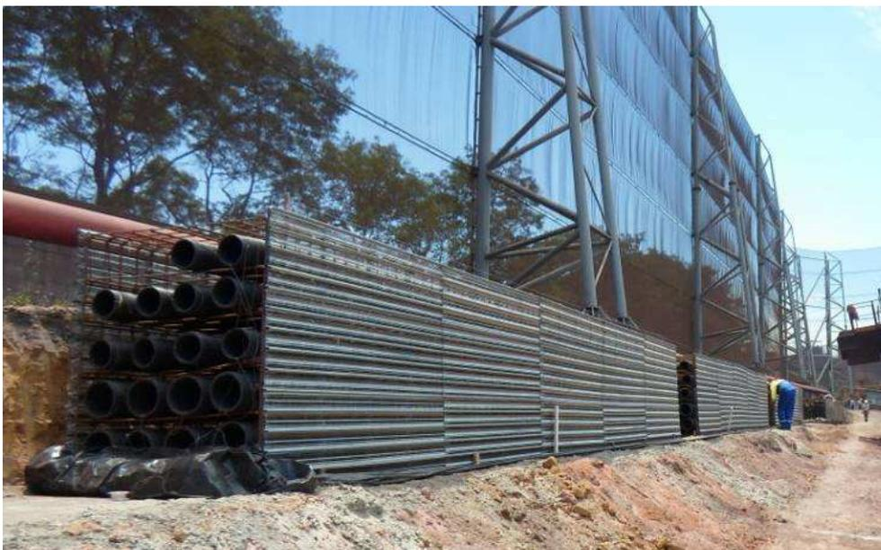
Figura 21 - Módulos de Envelopes prontos com *QuickJet*.
