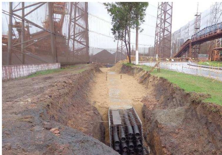
Figura 25 - Reaterro de envelope com areia adensada.
