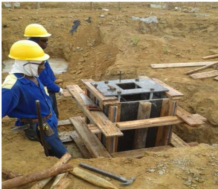
Figura 6 - Fôrma de madeira para pilarete de fundação.
