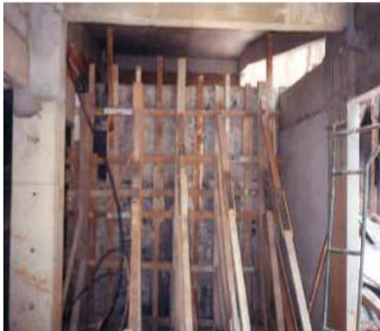
Figura 2 - Uso excessivo de madeira para fôrmas.
