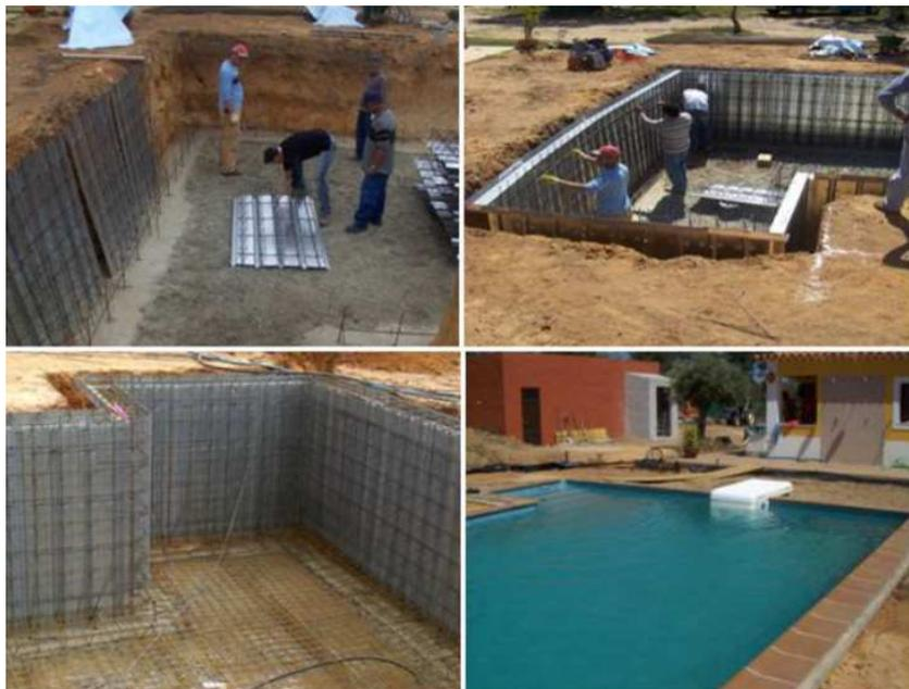
Figura 18 - Execução de piscina com fôrma em chapa de aço galvanizado.
