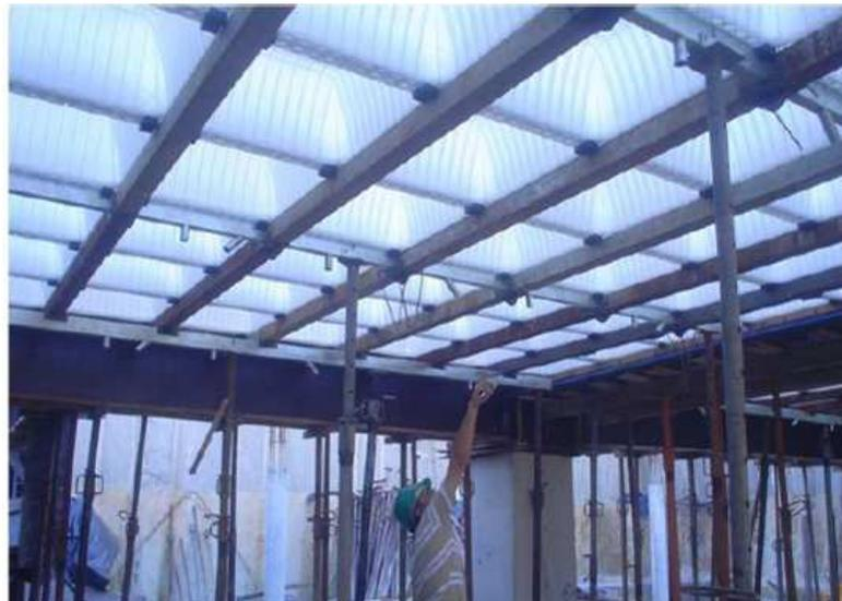
Figura 5 - Montagem de fôrmas plásticas para laje nervurada.
