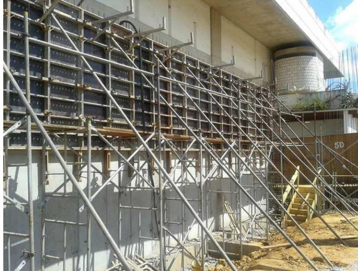
Figura 10 - Montagem de fôrma tipo Concreform SH.
