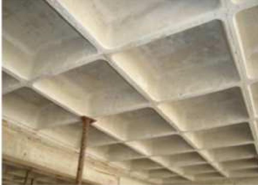
Figura 13 - Vista Inferior de laje nervurada executada com molde da Protensão Impacto.
