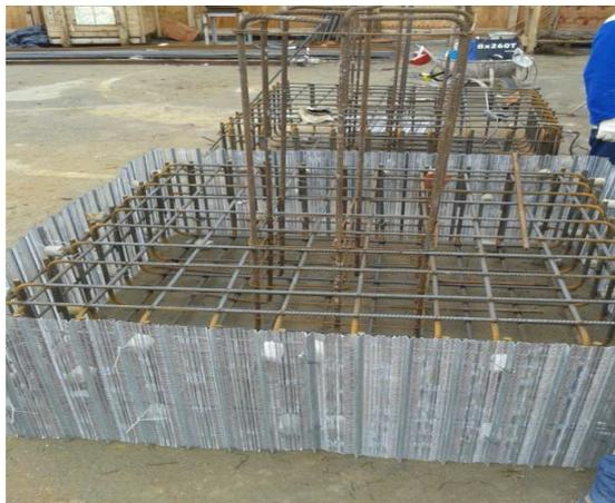
Figura 27 - Montagem de fôrma metálica perdida em sapata.
