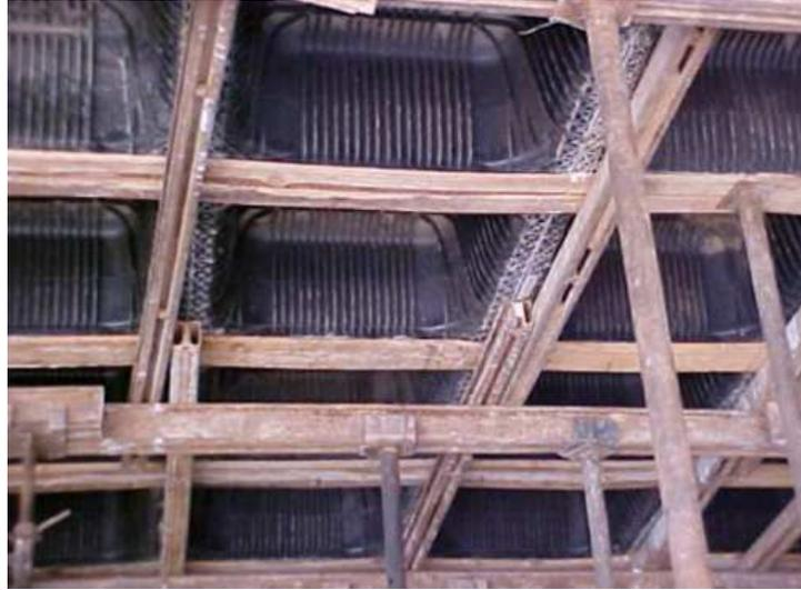
Figura 11 - Fôrma plástica na execução de laje nervurada.
