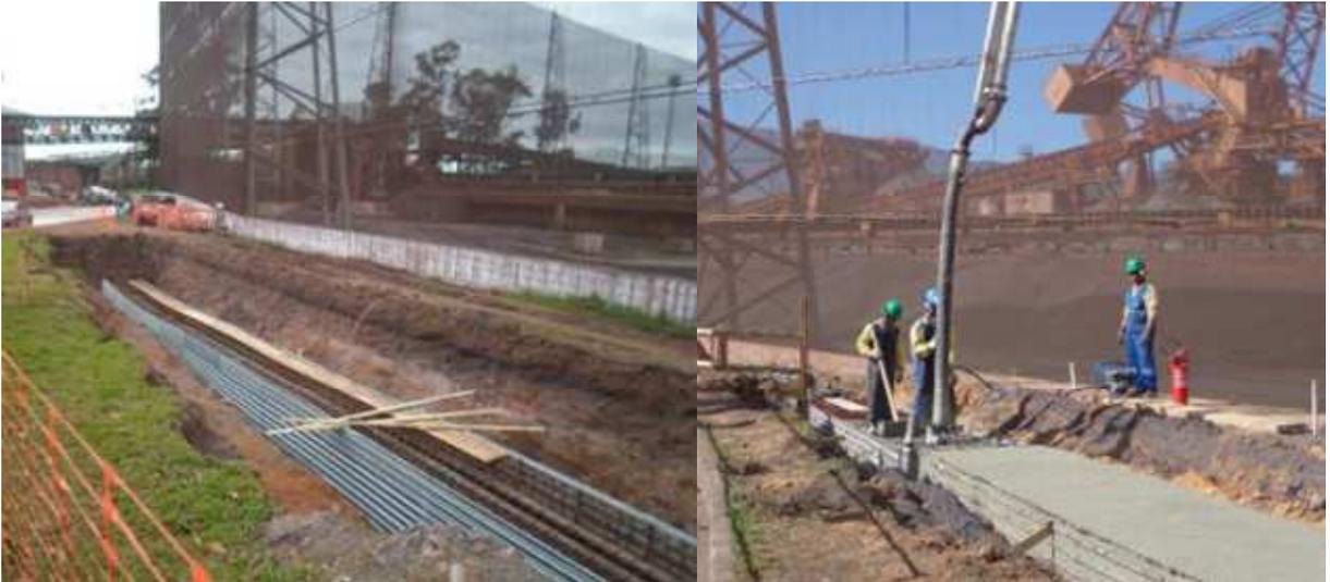
Figura 24 - Conclusão do posicionamento e concretagem de envelopes.
