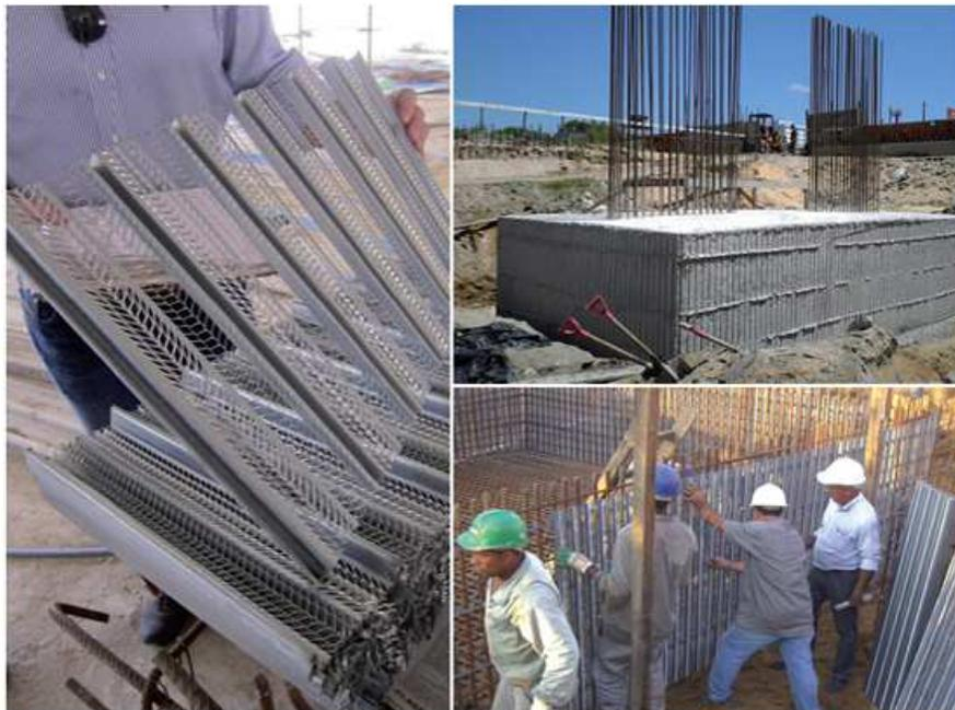
Figura 16 - Detalhe da tela e montagem do *QuickJet* em fundação.
