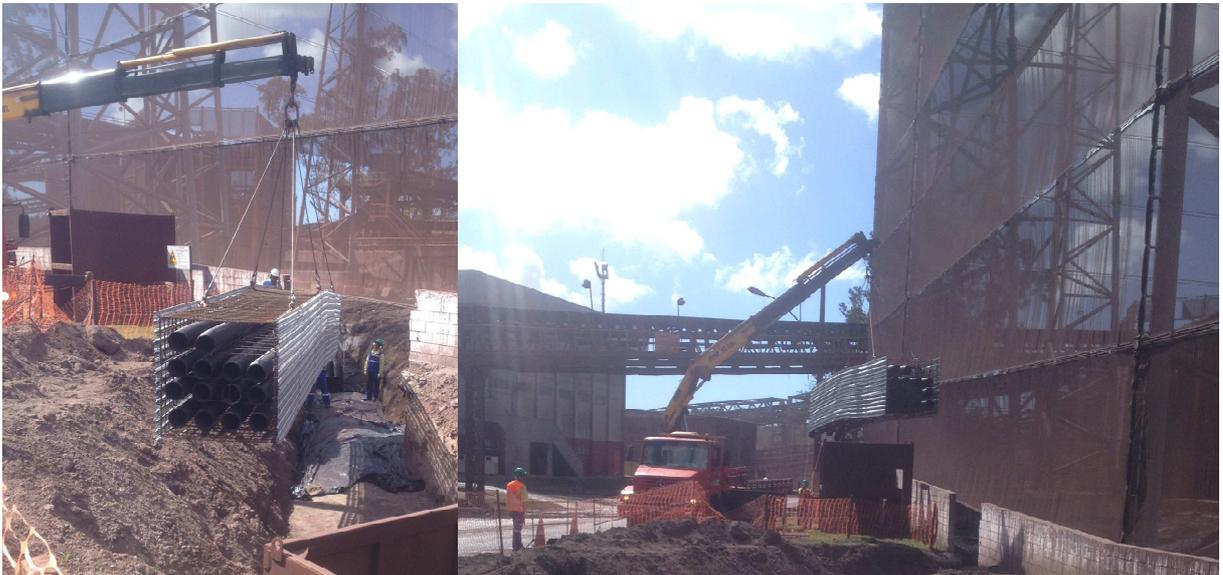
Figura 23 - Posicionamento de envelope montado em escavação.
