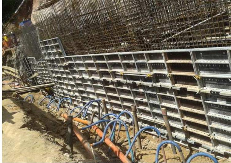
Figura 4 - Montagem de fôrma metálica - SAAE Linhares.
