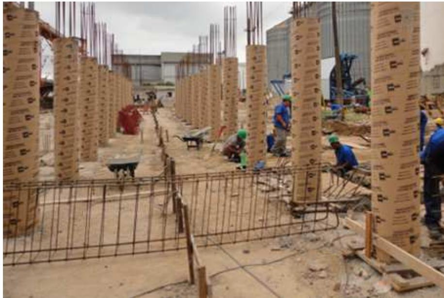
Figura 17 - Fôrma de papelão para execução de pilar.
