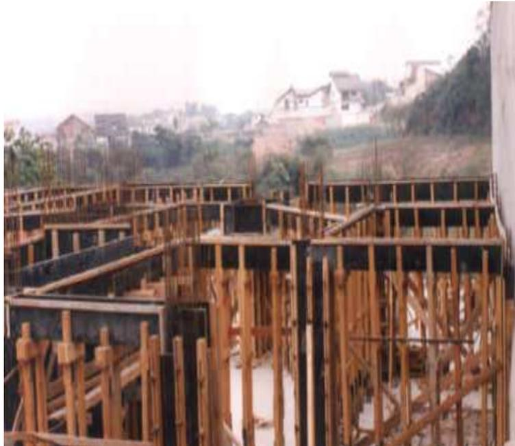
Figura 3 - Fôrma e escoramento pré-fabricados.
