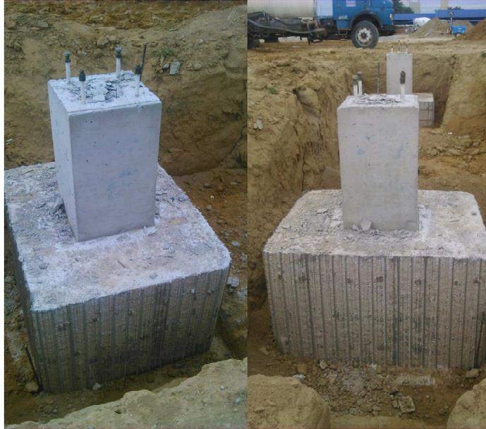
Figura 30 - Sapatas do Faça Fácil concretadas in loco.
