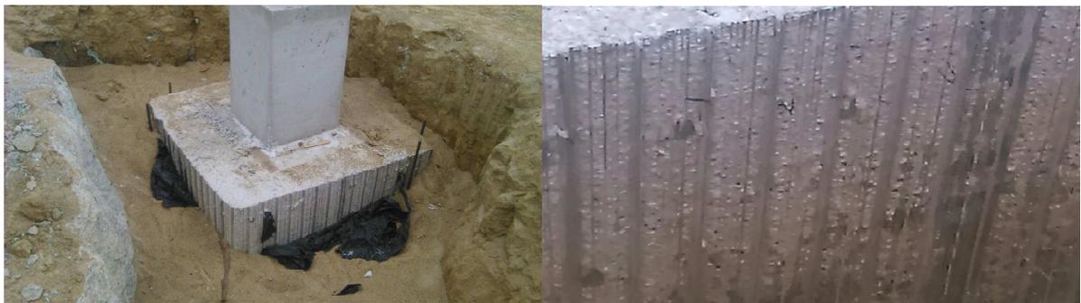
Figura 31 - Detalhe e reaterro da sapata do Faça Fácil.
