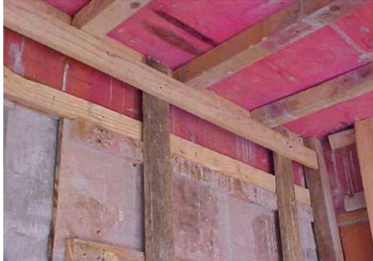
Figura 7 - Fôrma executada em madeira serrada.
