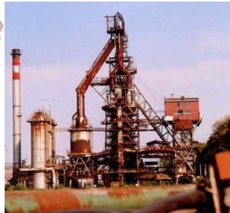
Blast furnace Antiguo Alto horno de Sestao, Spain; technical cultural monument
