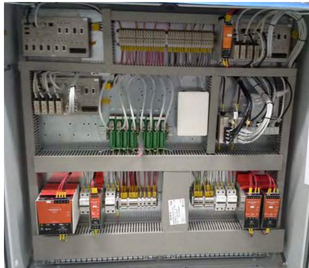
Ilustración 7.5 – Cabina de Control CC21 del buque Stril Luna (Rolls-Royce ACON-R)
