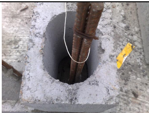
Figura 9 - Barra de aço dentro do bloco limpo, esperando o grout
