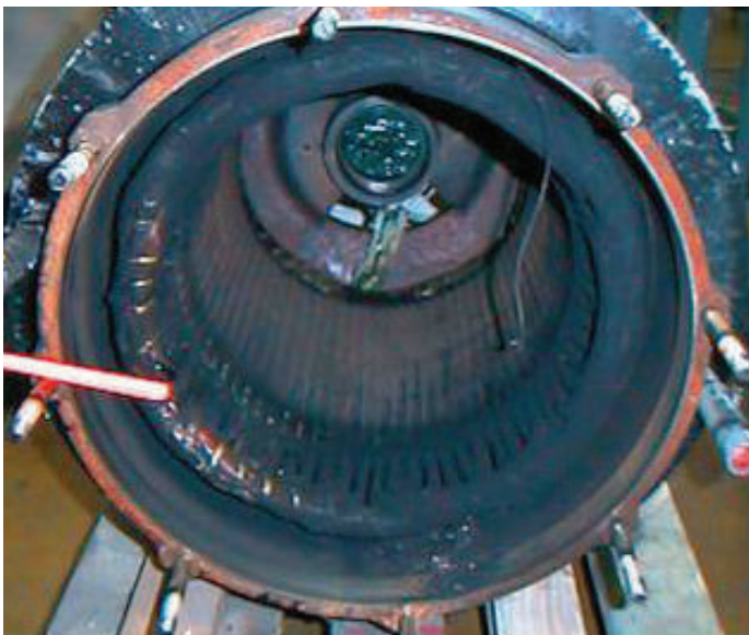
Figura 21. Decoloración general en el devanado del estator que normalmente indica excesiva temperatura. Verifique la carga, la alimentación eléctrica y el sistema de enfriamiento. Figura © EASA
