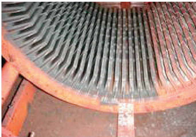
Figura 24. Este núcleo ha sido parcialmente limpiado con una lavadora de alta presión para remover de la ranura restos de aislamiento.
