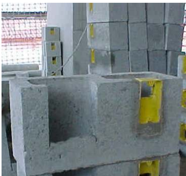
Figura 33 – Cortes com equipamentos adequados para embutimento prévio de caixas elétricas
