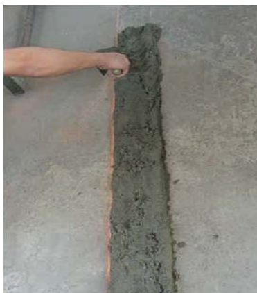
Figura 23 – Distribuir a argamassa para o assentamento da 1ª fiada
