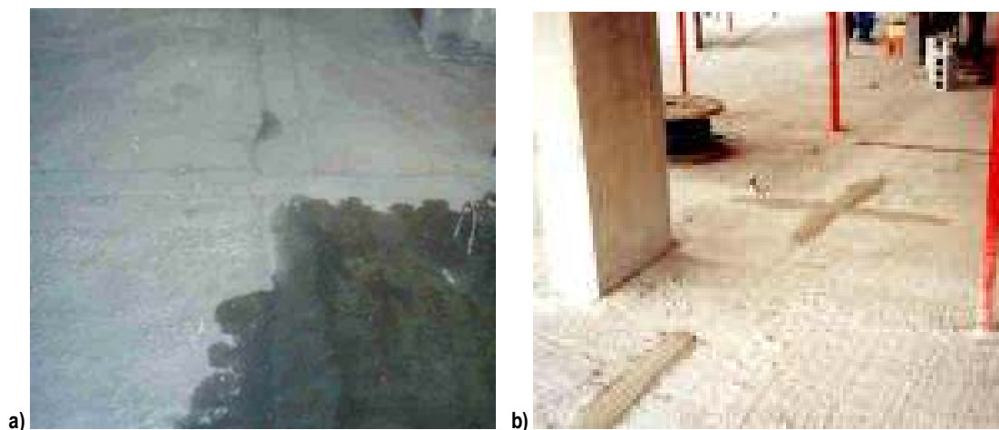
Figura 20 – Materialização dos eixos de referência: a) contínuo, b) intercalado
