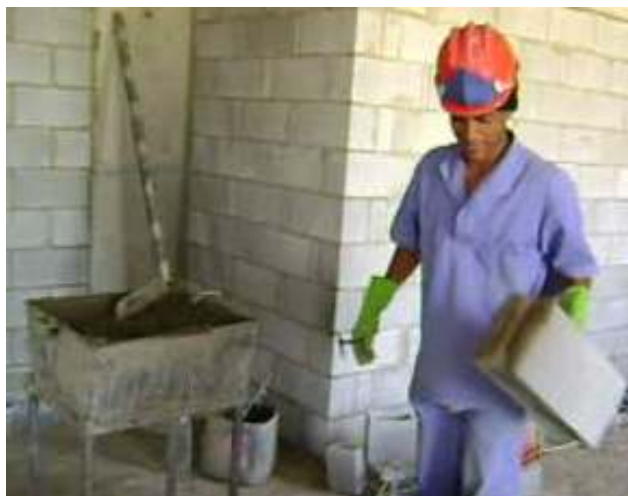
Figura 25 – Dois cordões de argamassa na junta vertical de assentamento
