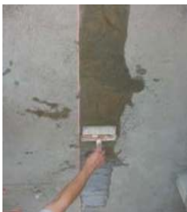
Figura 22 – Umedecer a superfície para o assentamento dos blocos da primeira fiada
