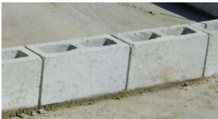
Figura 26 – Assentamento dos demais blocos da 1ª fiada
