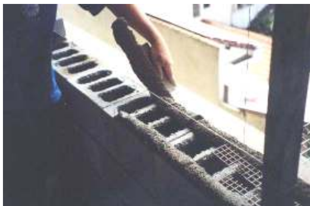
Figura 29 – Palheta utilizada para a aplicação dos cordões de argamassa
