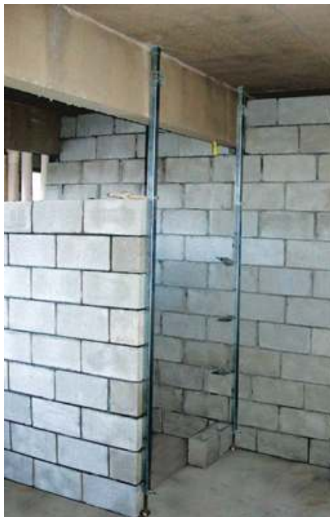
Figura 28 – Posicionamento do escantilhão
