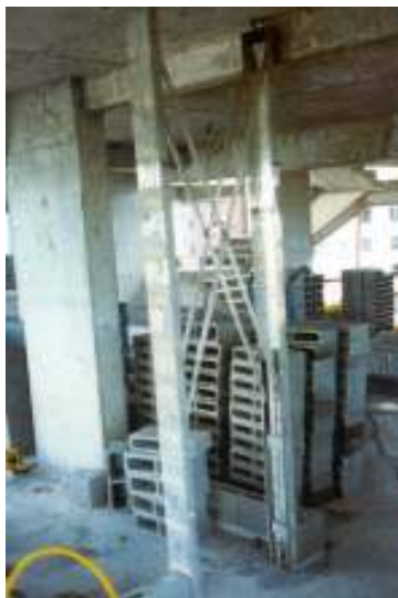
Figura 32 – Uso de gabaritos para a máxima precisão de vãos
