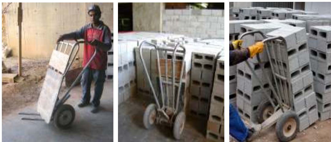
Figura 11 – Transporte de bloco com carrinho apropriado
