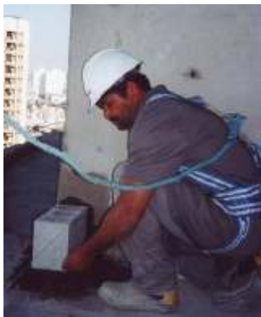
Figura 24 – Posicionamento de bloco da extremidade da parede
