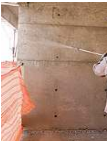
Figura 18 – Jateamento com água para a remoção de desmoldante da estrutura
