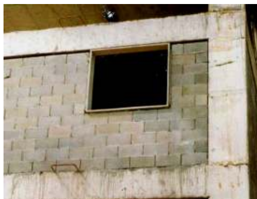
Figura 35 – Espaço deixado para fixação da alvenaria à estrutura
